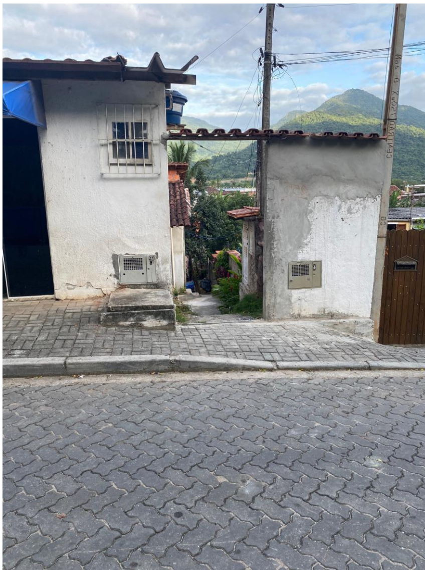
Anexo III. Entrada do imóvel.
