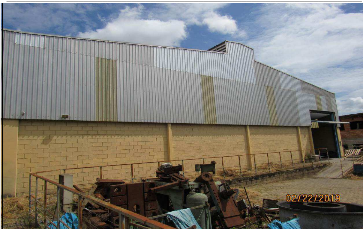
FOTO 08 – Vista geral frontal do galpão industrial.
