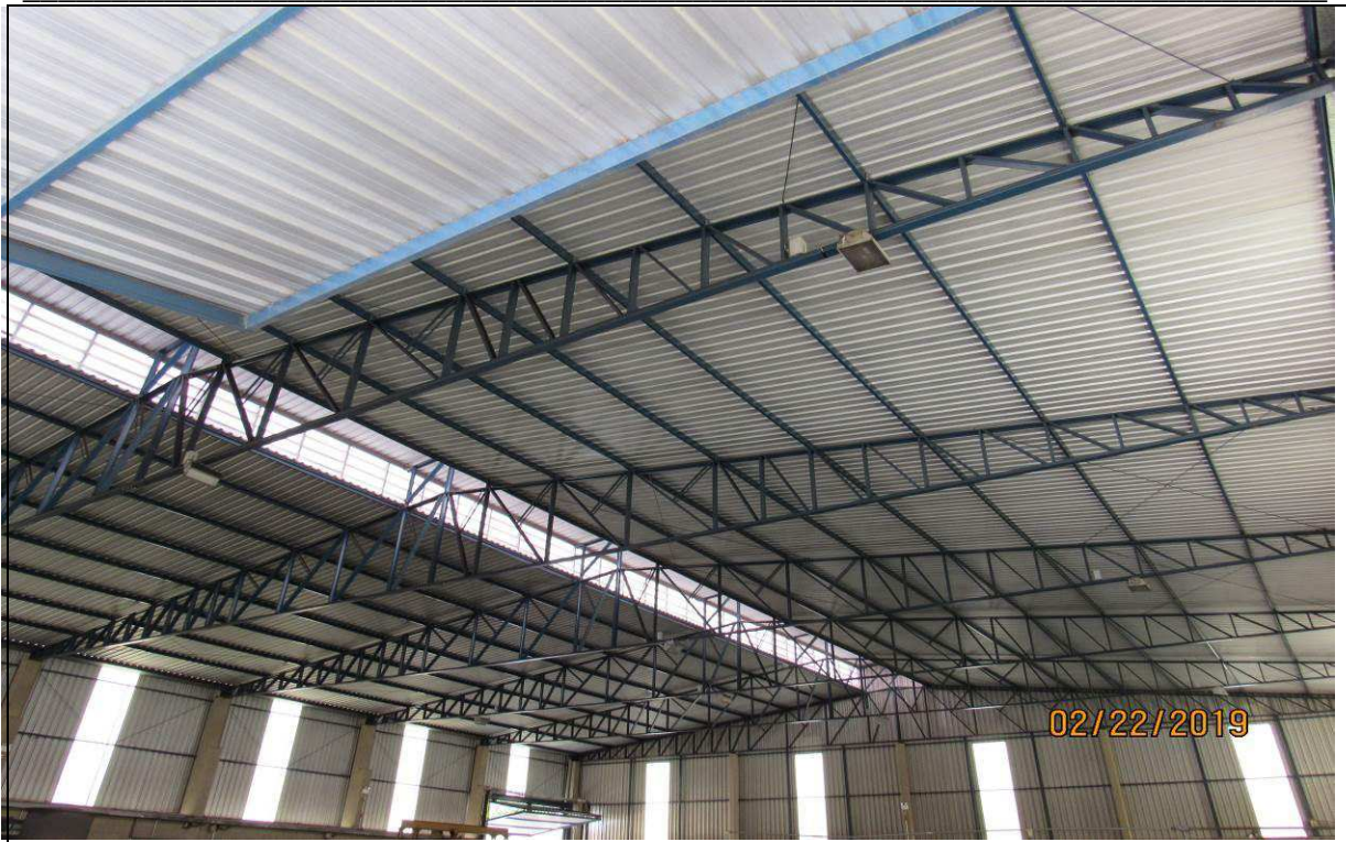
FOTO 04 – Vista geral da estrutura metálica e cobertura do galpão industrial.
