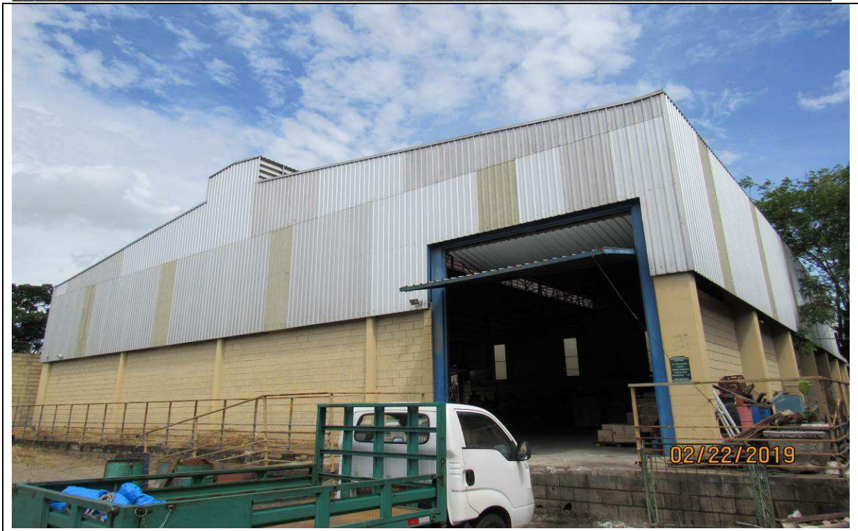
FOTO 02 – Vista frontal do galpão industrial.
