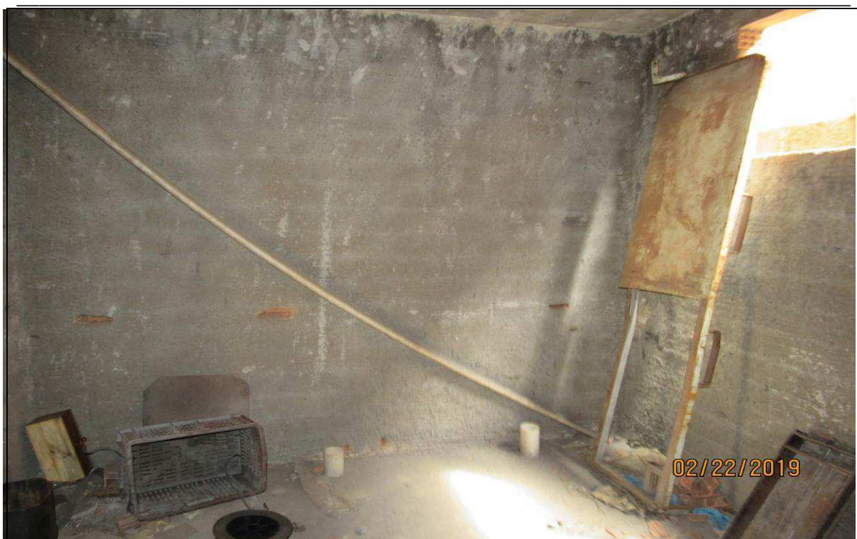
FOTO 14 – Vista interna do sobrado inacabado.
