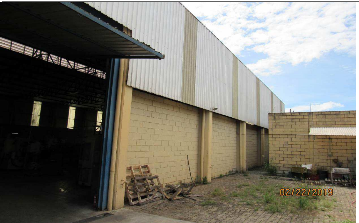
FOTO 05 – Vista externa nos fundos do galpão industrial.
