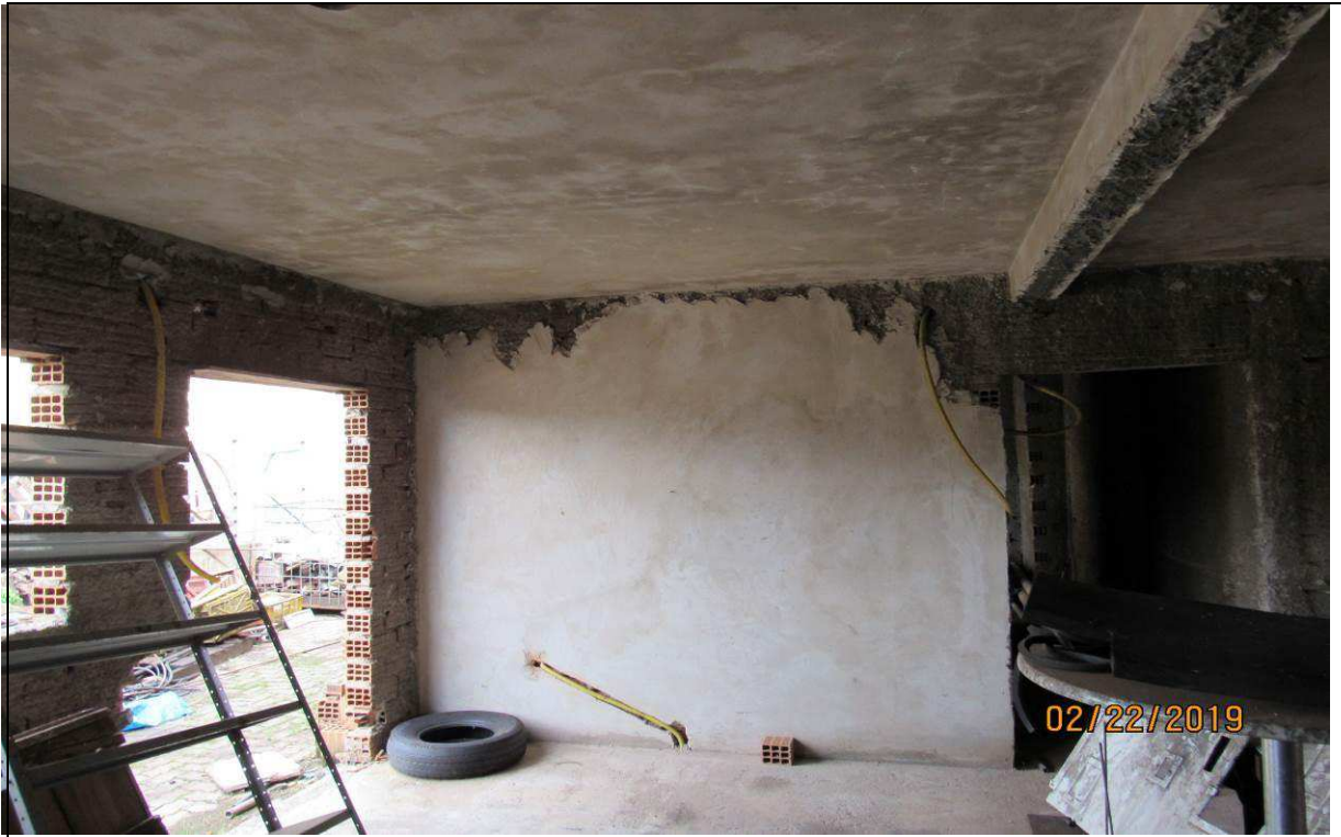
FOTO 12 – Vista interna do sobrado inacabado.
