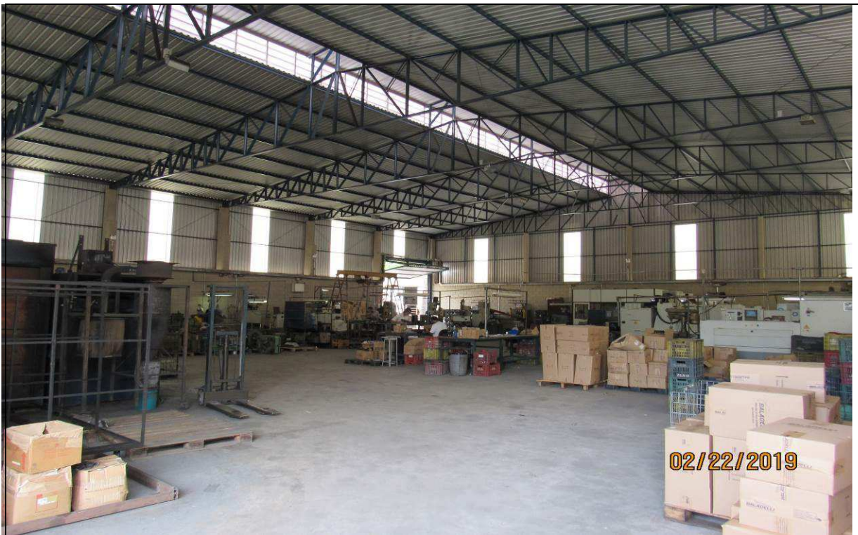
FOTO 03 – Vista interna do galpão industrial.
