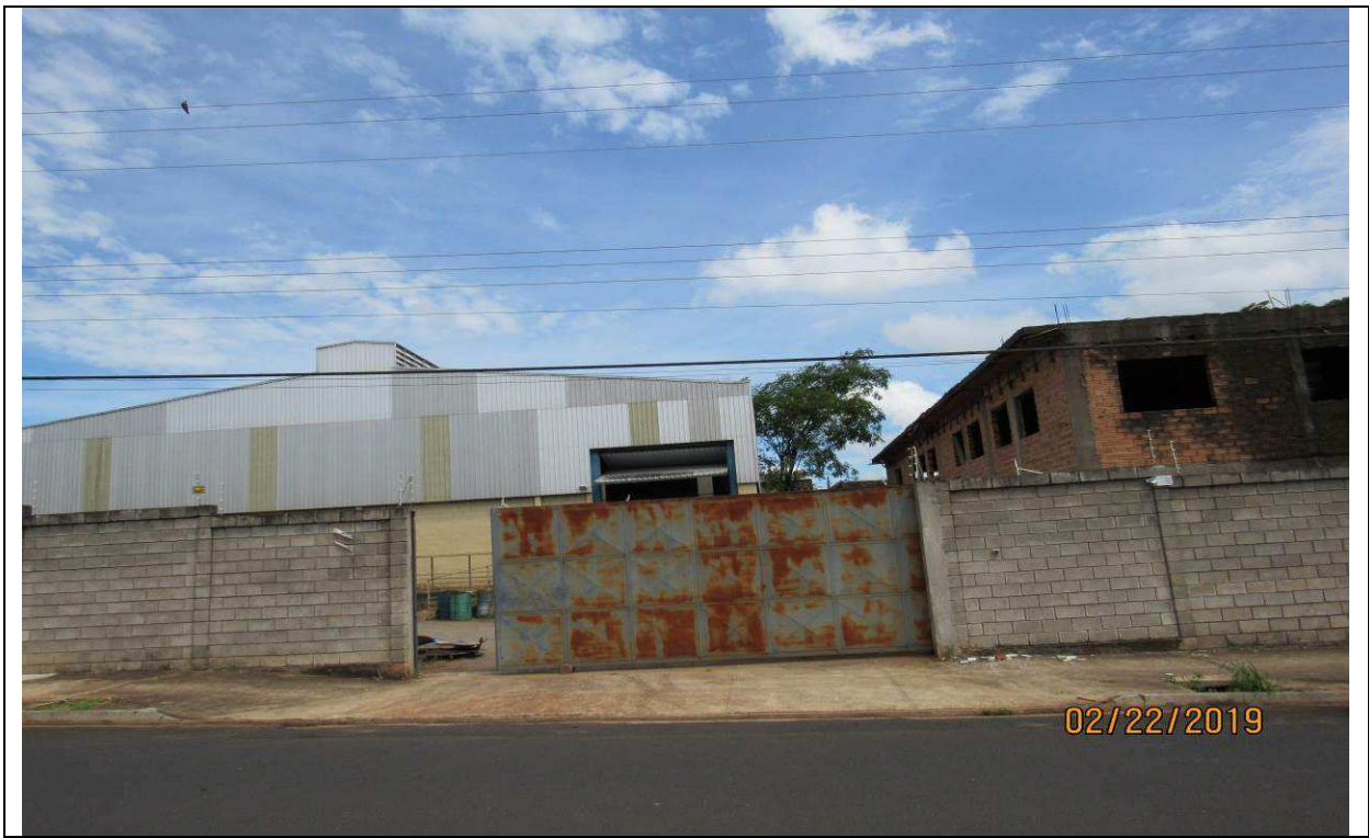
FOTO 01 – Vista geral frontal do imóvel avaliando.
