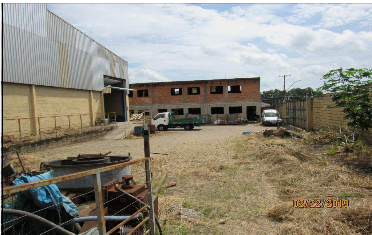
FOTO 09– Vista geral frontal da construção assobradada inacabada.
