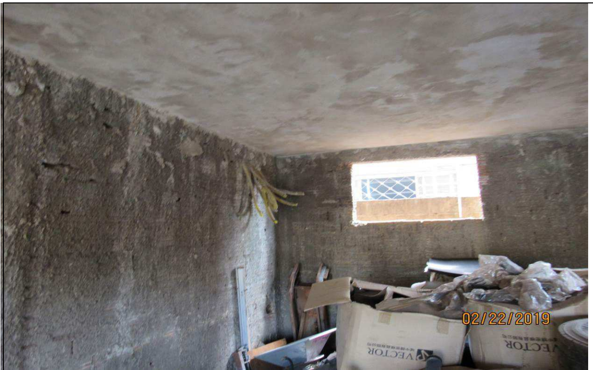
FOTO 13 – Vista interna do sobrado inacabado.
