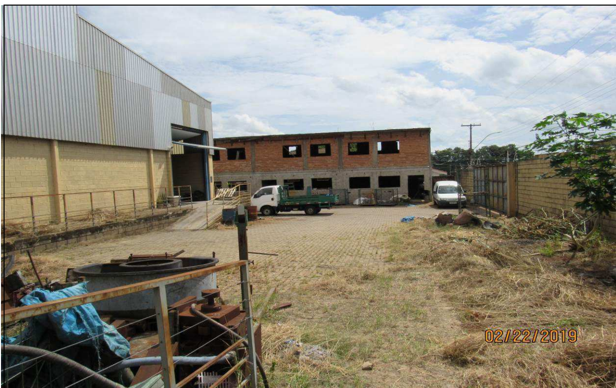
FOTO 09– Vista geral frontal da construção assobradada inacabada.
