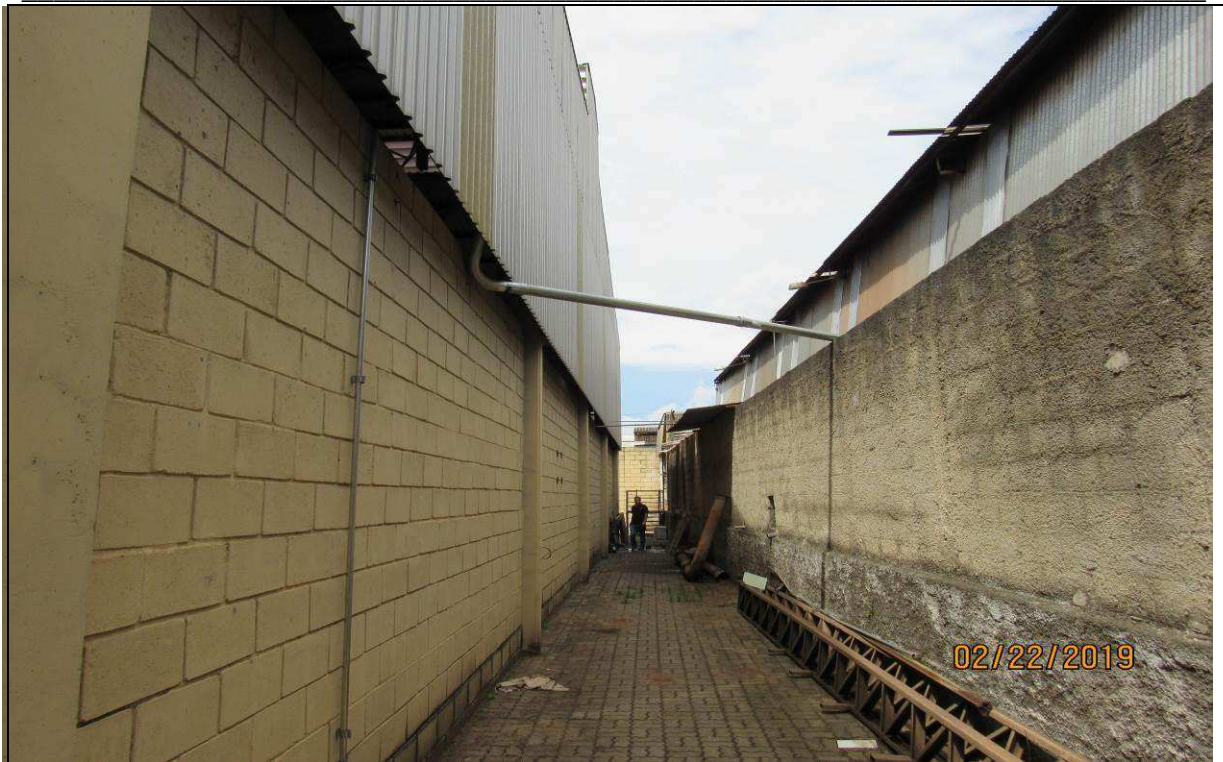
FOTO 06 – Vista externa lateral do imóvel.
