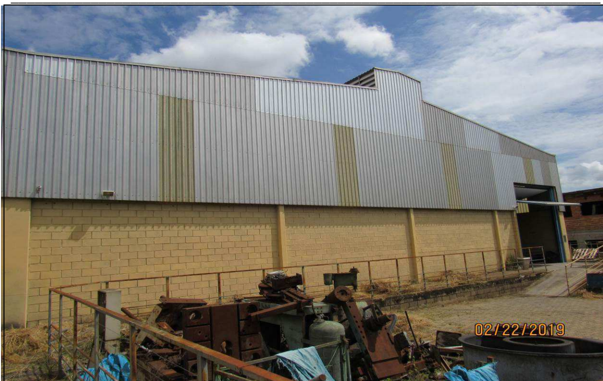
FOTO 08 – Vista geral frontal do galpão industrial.
