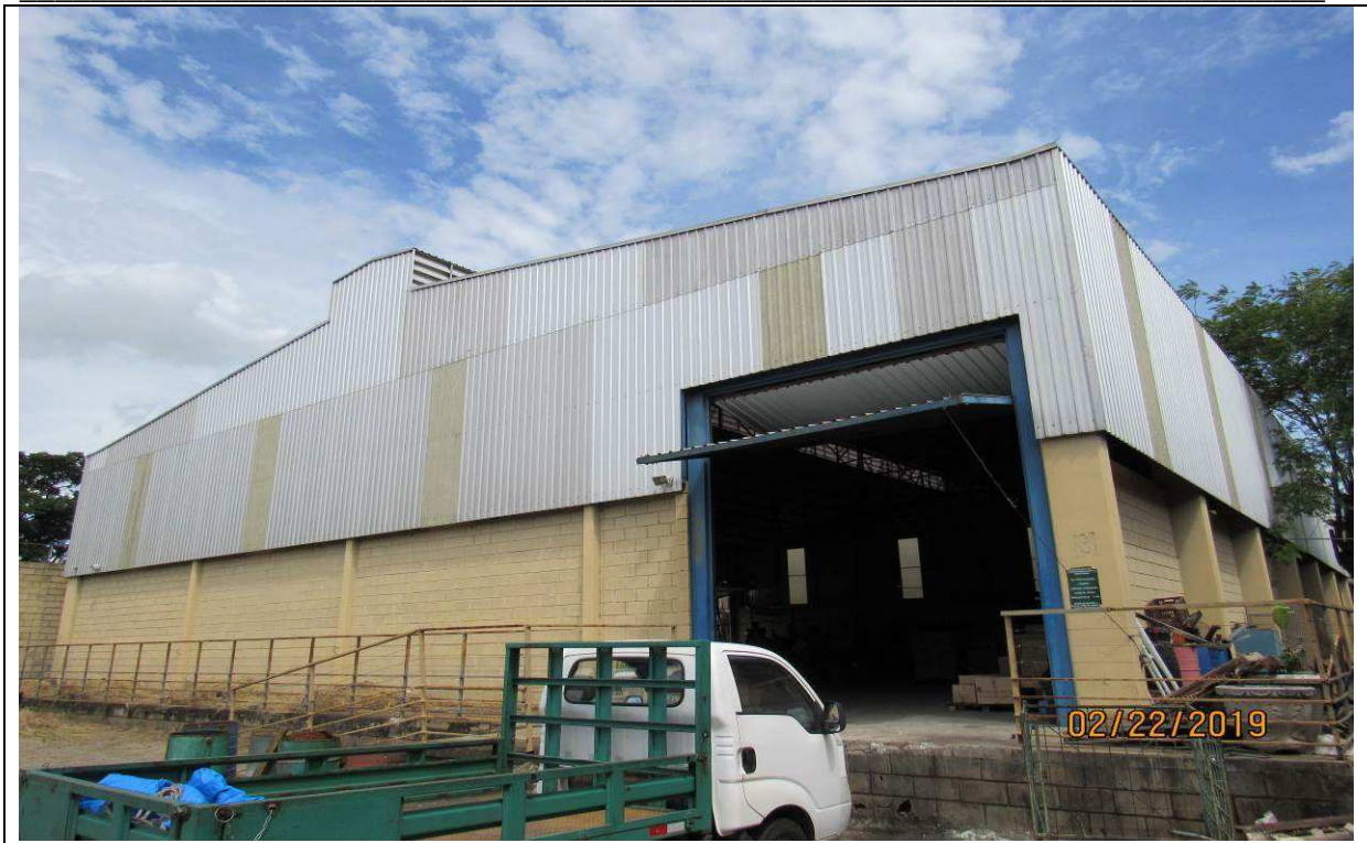
FOTO 02 – Vista frontal do galpão industrial.
