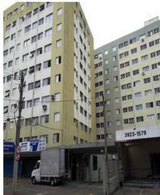
Foto 2 – Entrada condomínio Suíte Service
