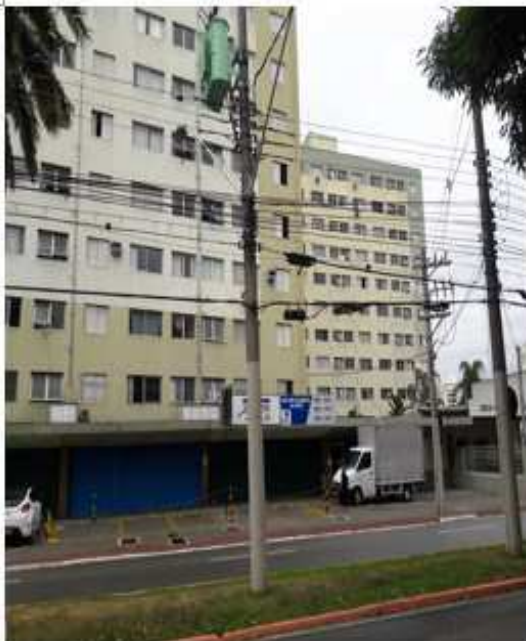
Foto 1 – Fachada do imóvel
