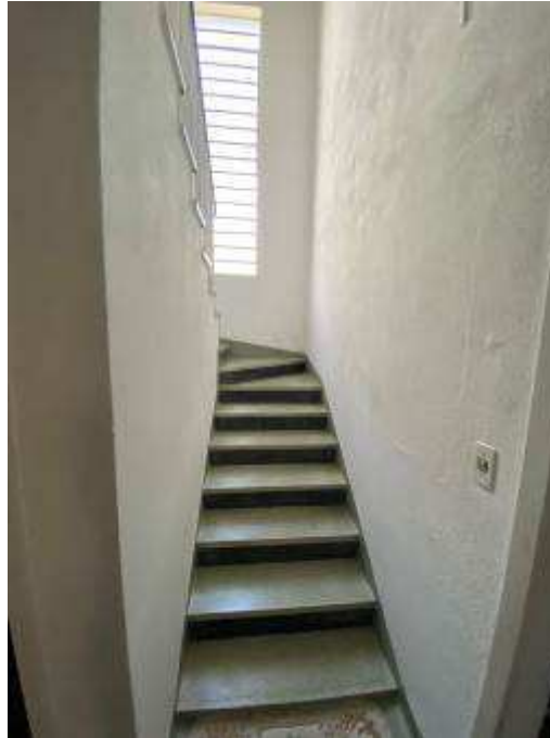
VISTA DA ESCADA DE ACESSO AO PAVIMENTO SUPERIOR.
