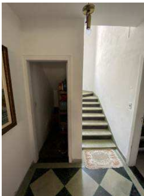
VISTA DO DEPÓSITO.
