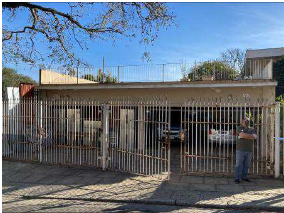
VISTA DA ENTRADA DO IMÓVEL.
