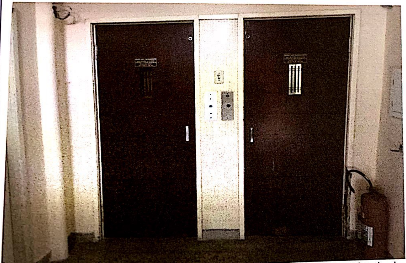
FOTO 07 – Vista parcial da área comum (hall e corredores) e os elevadores no 6º andar do Edifício (Apartamento nº 623).
