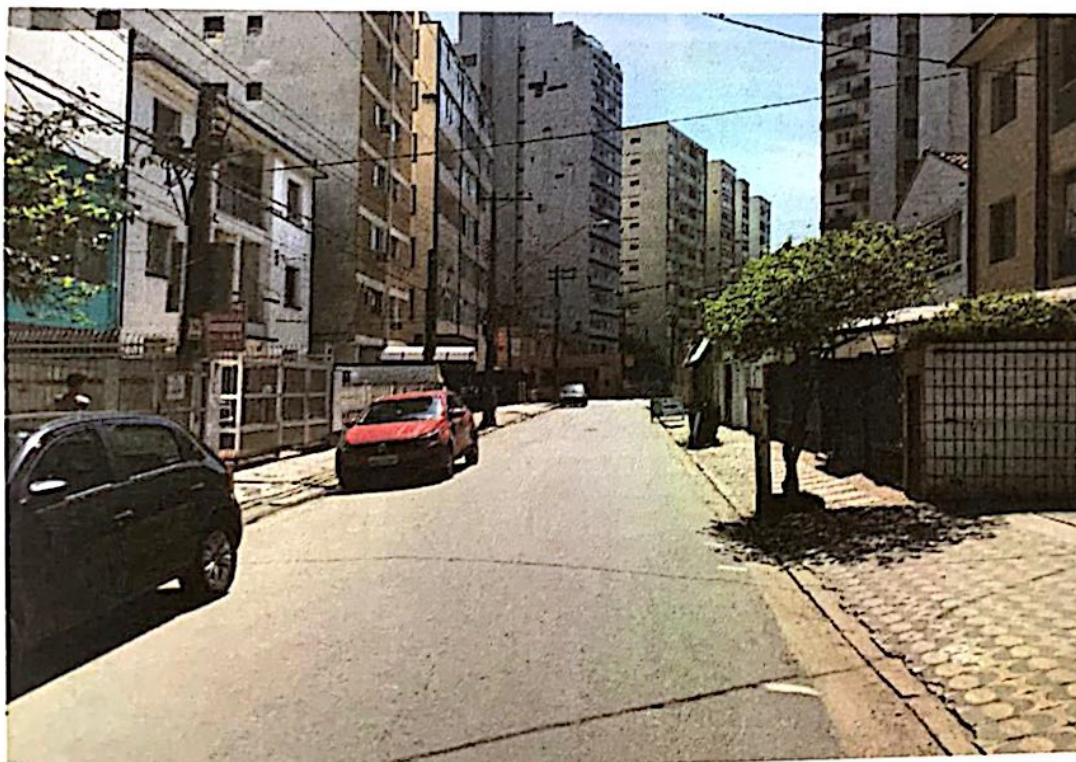
FOTO 03 – Vista parcial da mesma Rua José Francisco Valença (sentido Rua João Ribeiro).
