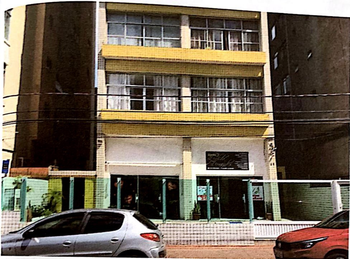
FOTO 04 - Vista parcial da fachada principal do Edifício Alpha onde se situa o imóvel avaliando.
