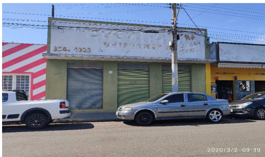
Vista parcial do imóvel 3 avaliado, sito à Rua Gentil Moreira nº 789
