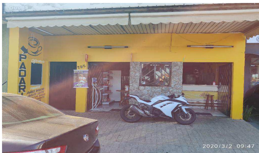
Vista parcial do imóvel 4 avaliado, sito à Rua Gentil Moreira nº 795
