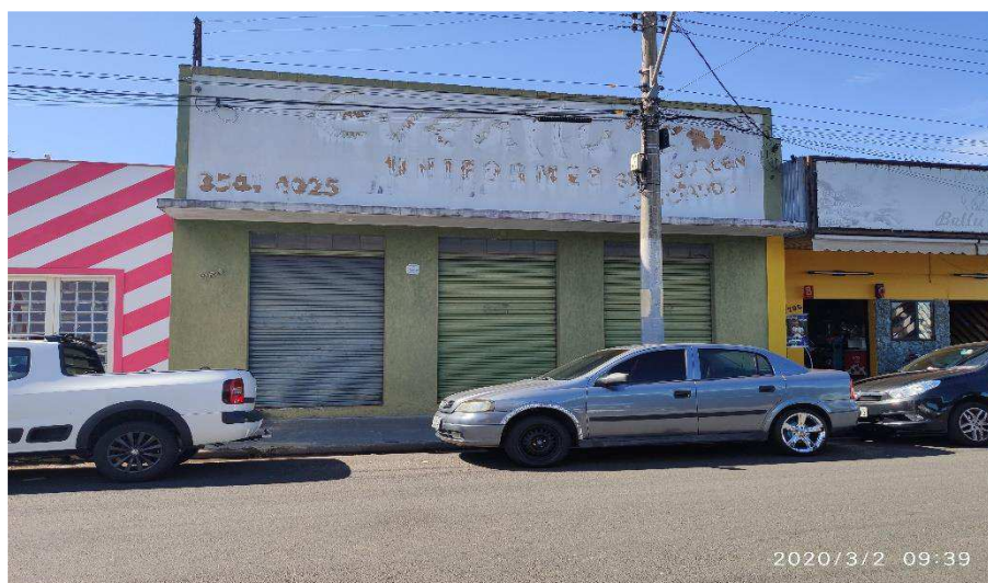
Vista parcial do imóvel 3 avaliado, sito à Rua Gentil Moreira nº 789
