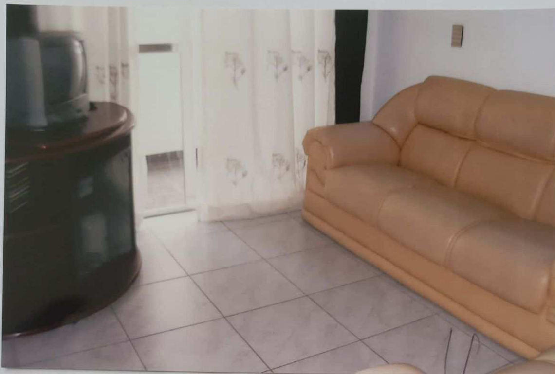
foto nº 12 - sala de estar do apartamento nº 86-avaliando, com piso de porcelanato e portal de acesso à sacada de alumínio.
