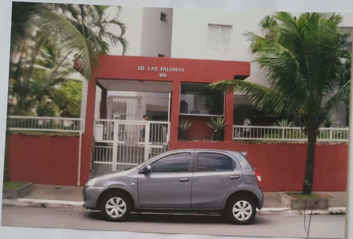
Foto nº 4 – detalhe da fachada do Edifício Las Palomas
