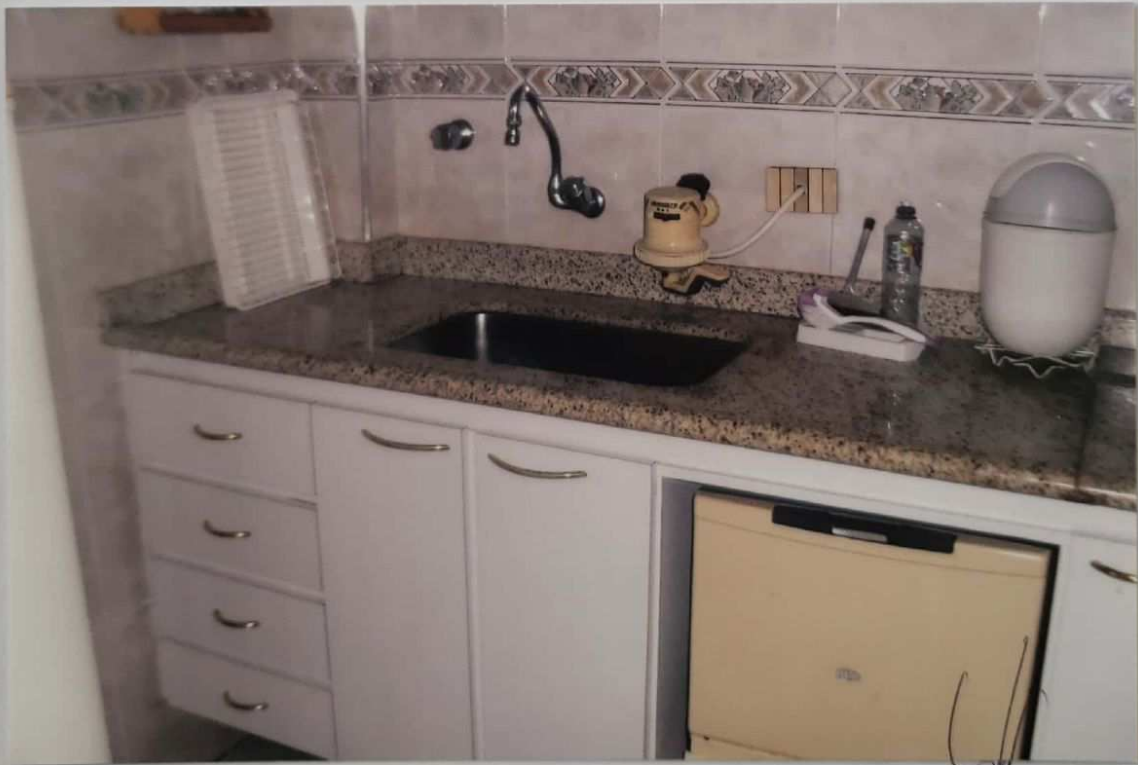
Foto nº 19 – cozinha com piso e paredes revestidos de porcelanato, pia com cuba inox e tampo de granito e armários de madeira
