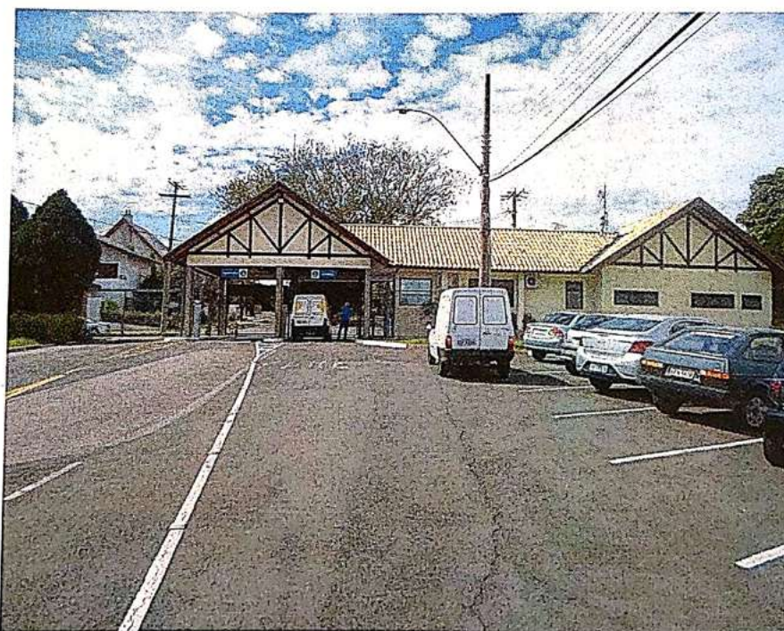
Na imagem acima, tem-se uma tomada da fachada do condomínio avaliando.
