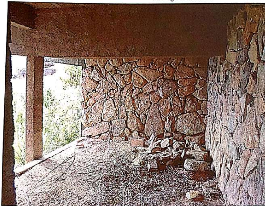
Acima e abaixo tem-se tomadas da edificação, onde nota-se as paredes parcialmente revestidas em pedra.
