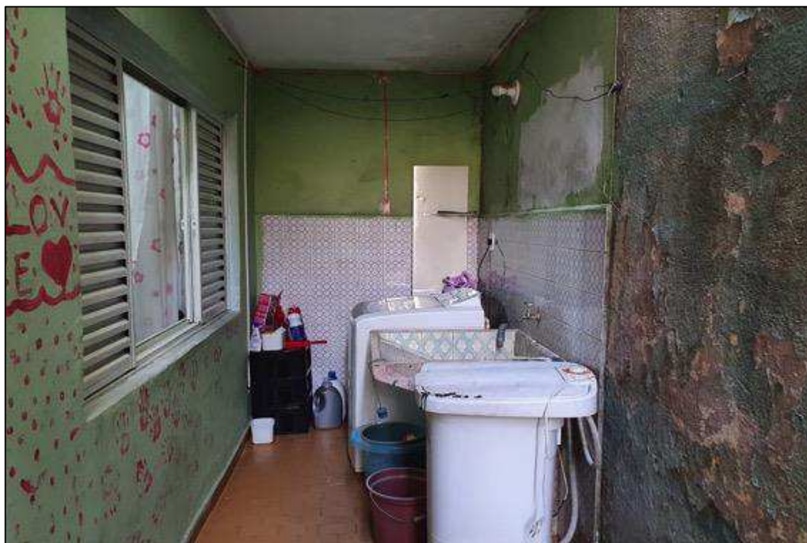
FOTO Nº 10 – Vista da lavanderia no imóvel avaliando.
