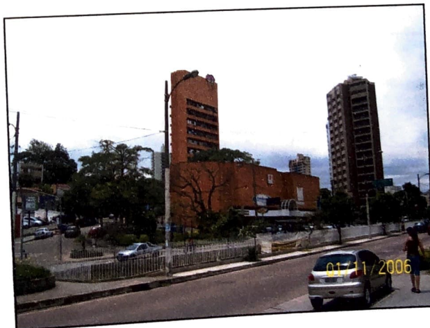
Vistas externas do Shopping Paineiras Center, a partir da Av. Nove de Julho.
