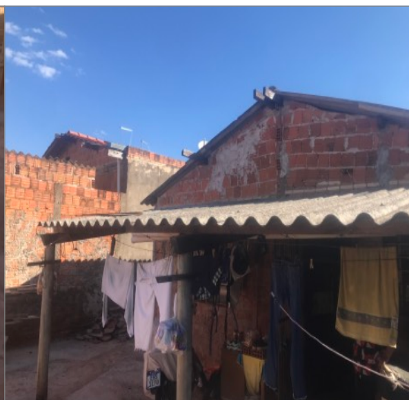
Imagem 09 – Tomada fotográfica ilustrando área de serviço coberta.
