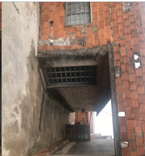
Imagem 03 – Ilustra corredor lateral direito. Detalhe para piso cimentado.
