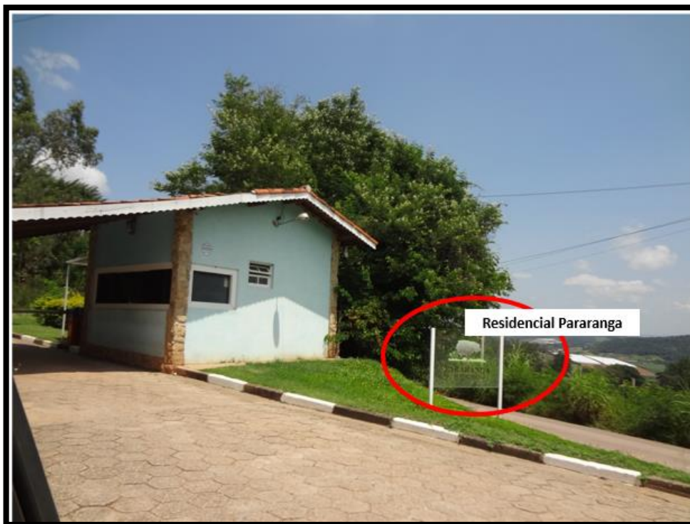
FOTO 01: Na ESTRADA DA PARARANGA tomar o portal de acesso para o Residencial Pararanga. É através deste Residencial que é possível alcançar a Portaria de acesso para o Village D’Atibaia.
