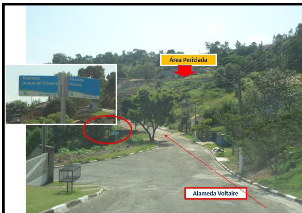
FOTO 09: Vista do trecho de intercessão da Alameda Duque de Orleans com a ALAMEDA VOLTAIRE, já sendo possível o contato visual com a área periciada.
