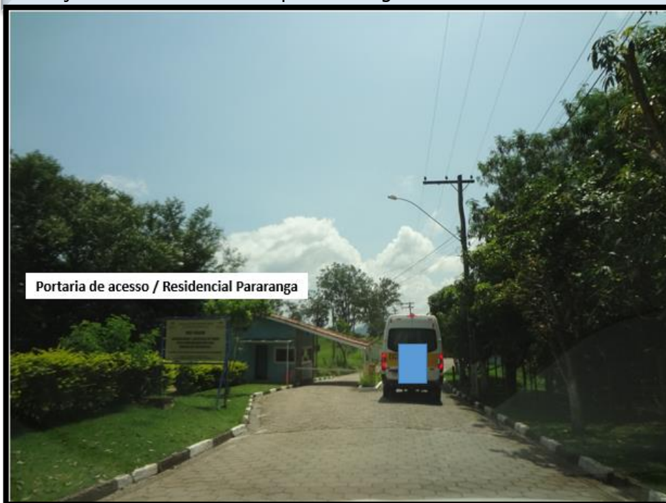
FOTO 02: Vista após a Portaria de acesso do Residencial Pararanga. Todo acesso de rodagem até próximo a Portaria do Village D’ Atibaia é feita por leito de rodagem sobre elementos sextavados em concreto.
