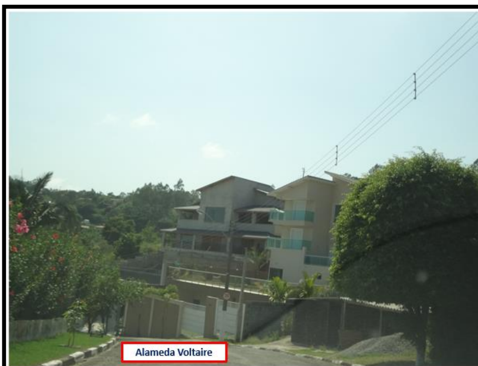
FOTO 07: Vista do trecho inicial da ALAMEDA VOLTAIRE de quem tendo passado pela Portaria de acesso ao Loteamento, segue em direção à área periciada.
