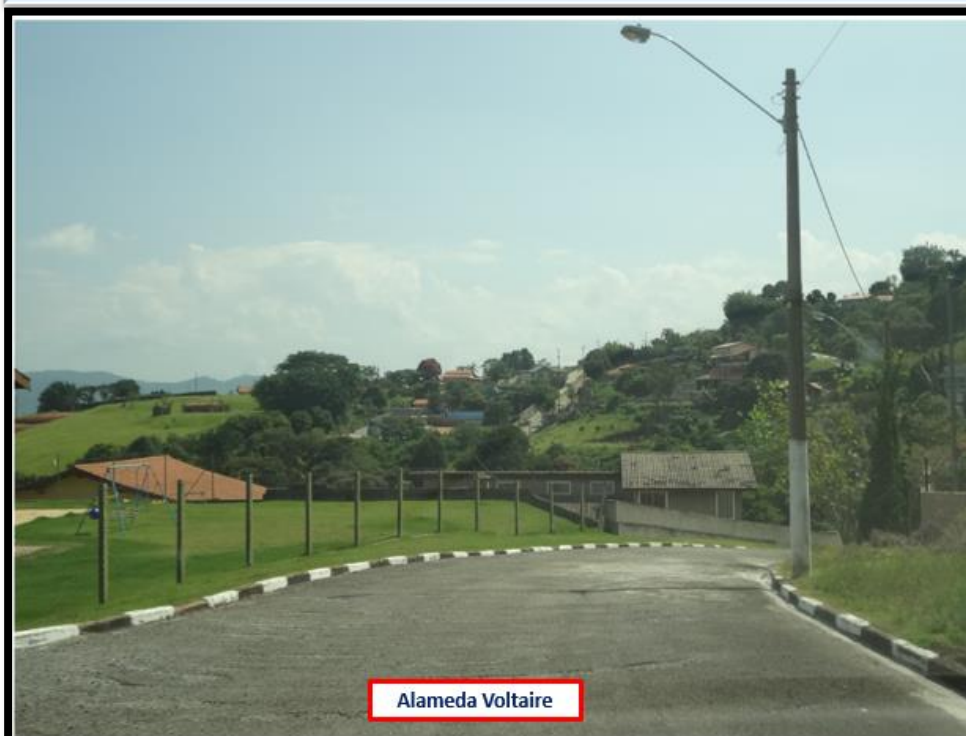
FOTO 08: Vista de meio trecho de extensão da ALAMEDA VOLTAIRE de quem tendo passado pela Portaria de acesso ao Loteamento, segue em direção à área periciada.
