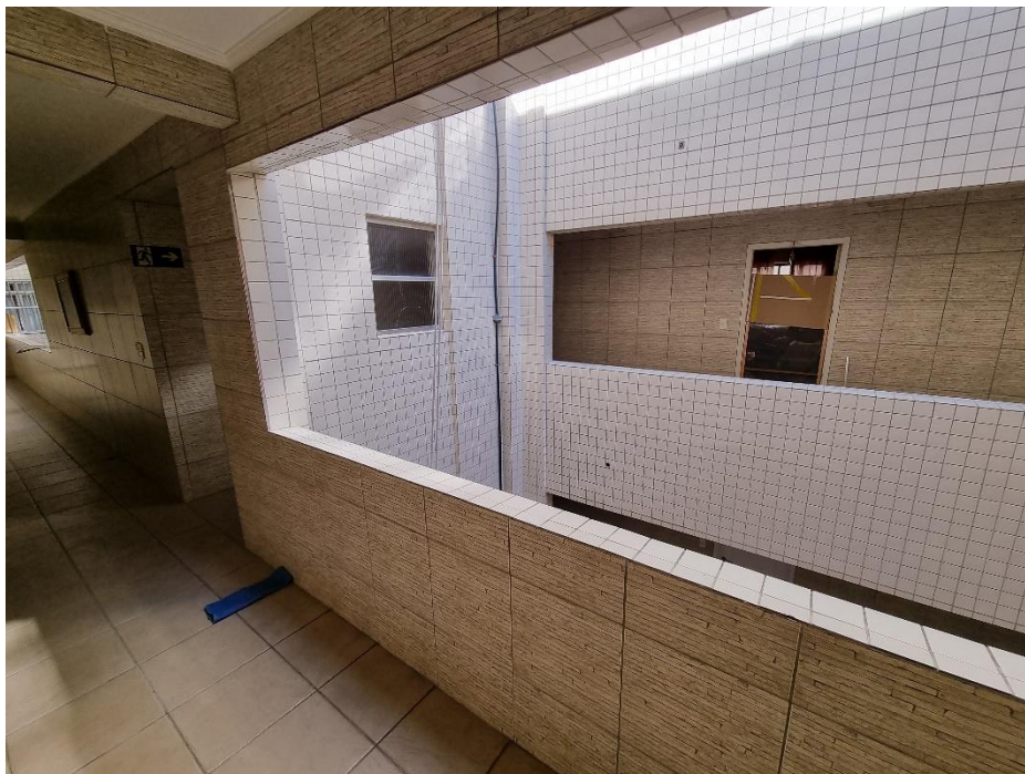
Foto 09 – Vista do corredor do 2º andar do Edifício Ana Cláudia.
