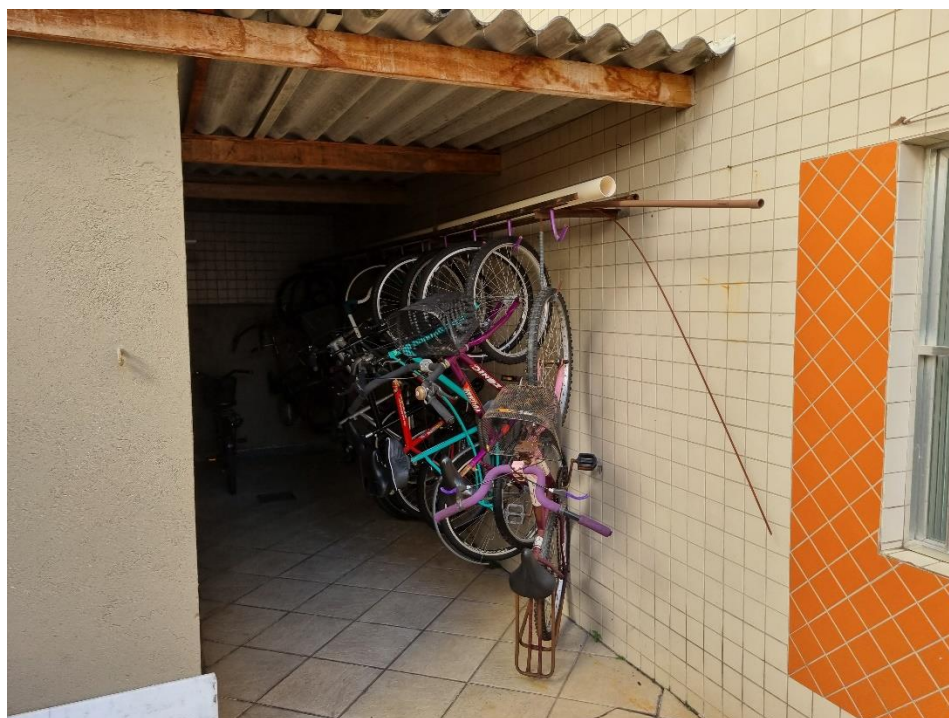
Foto 06 – Vista do bicicletário do Edifício Ana Cláudia.
