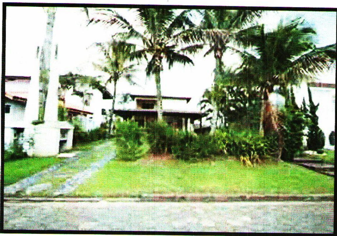
Imagem 01 – Fachada principal do Imóvel Avaliando.
