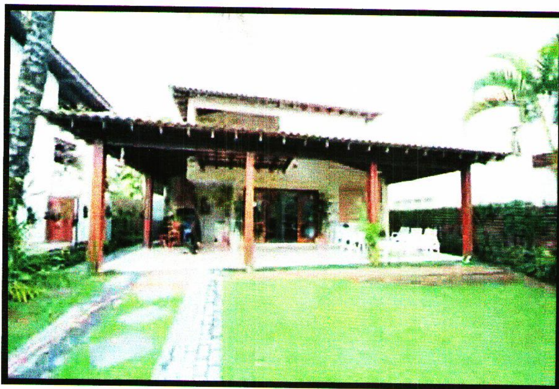
Imagem 02 – Fachada frontal do Imóvel Avaliando.
