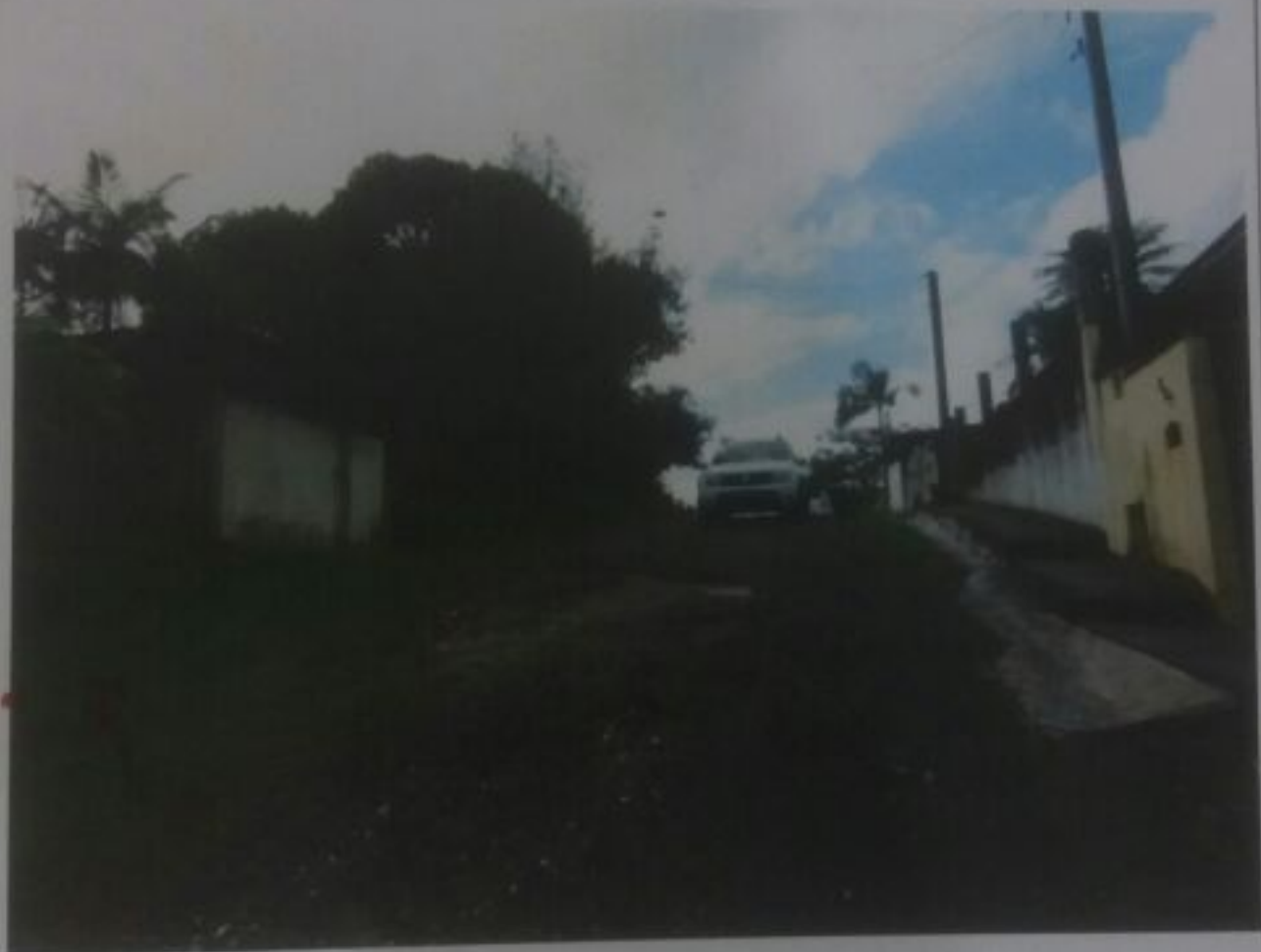
Foto 05 – Vista da rua de acesso de quem olha do final da área, próximo ao córrego de divisa
