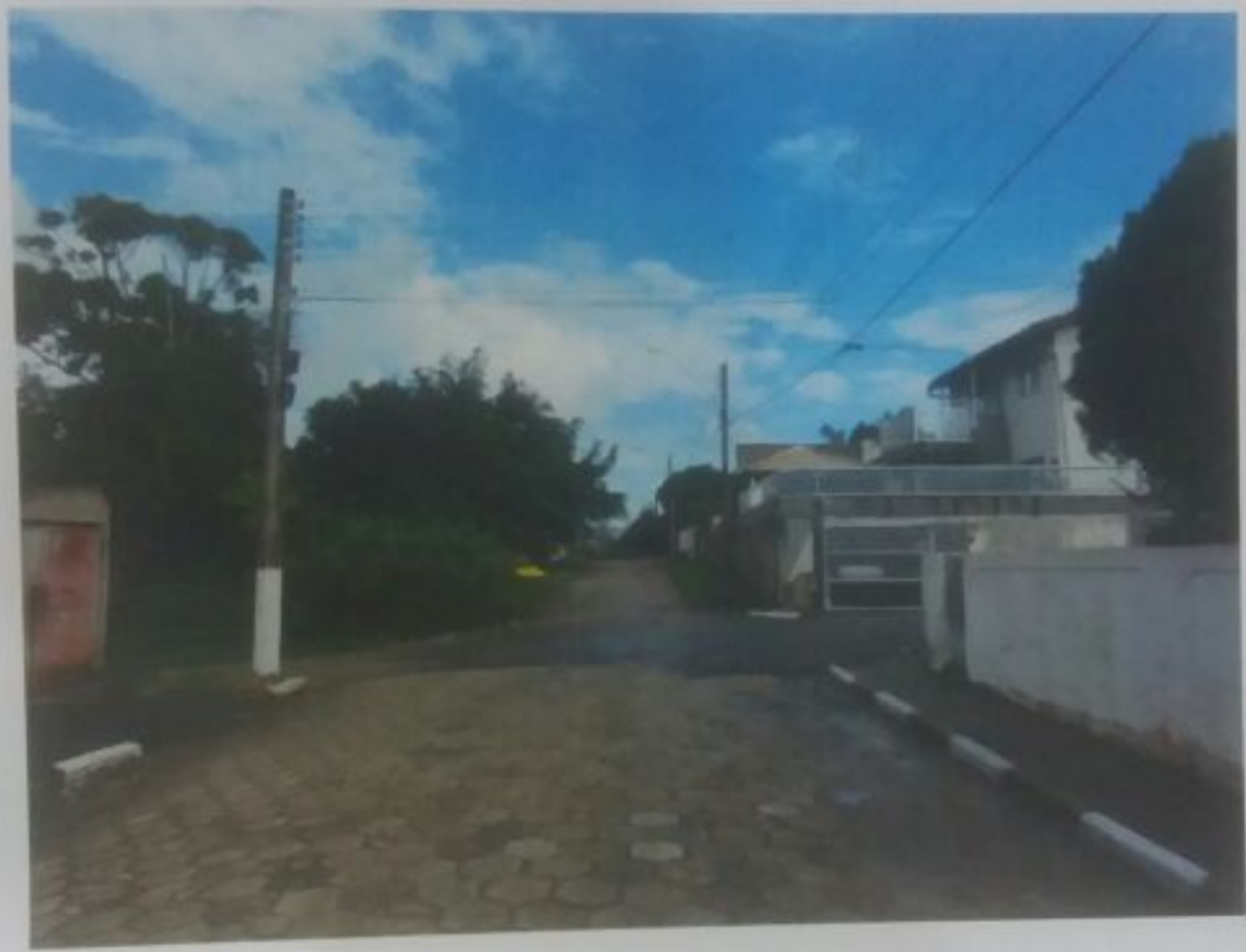
Foto 01 – Vista da rua de acesso à área avalianda (Rua Virgílio Zanella)
