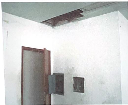
Foto batida no pavimento térreo e que permite observar os danos que o imóvel vem sofrendo em razão de depredações ocorridas.
