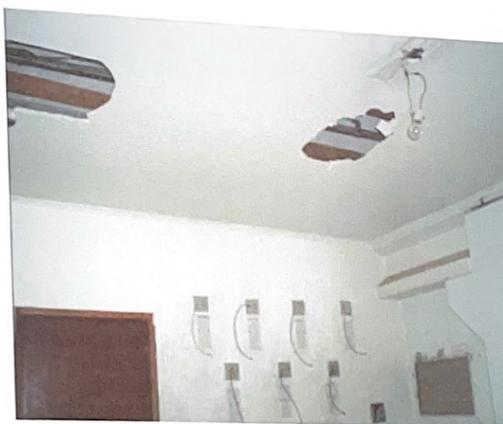
Vista interna no pavimento térreo mostrando danos no forro de gesso e componentes elétricos.
