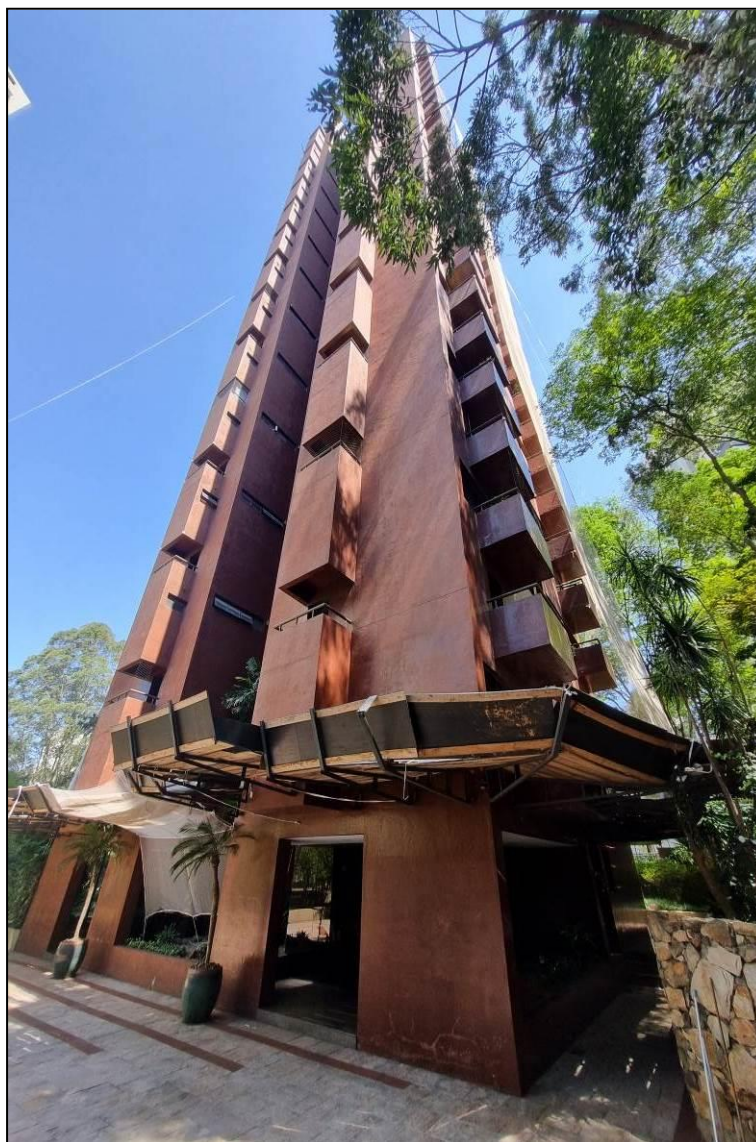
Foto nº 3: Vista geral do Edifício Marc Chagall.
