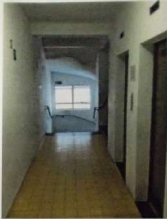
Hall dos Pavimentos Tipo
