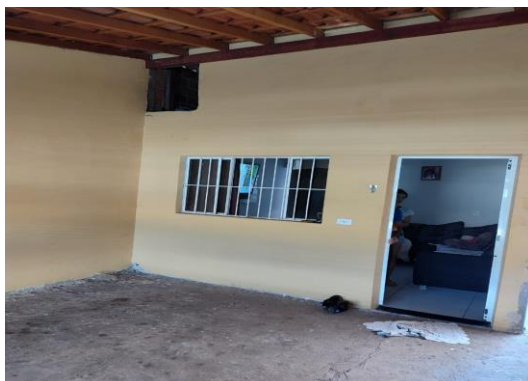
Vista da fachada do imóvel do Sr. Antônio, n° 73A
