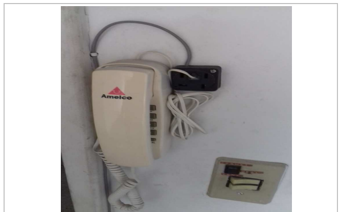
INTERFONE NECESSITA MANUTENÇÃO
