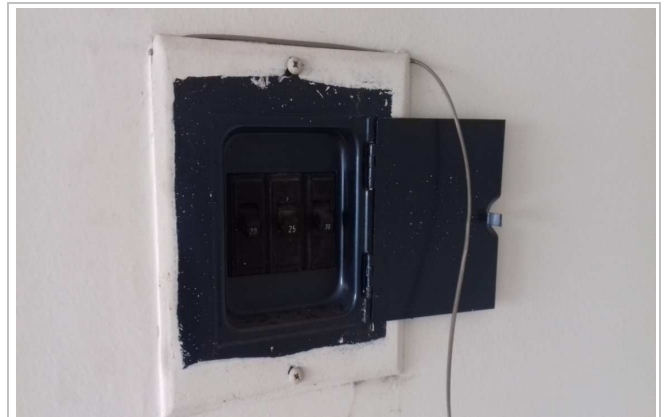
QDL (AVALIANDO NECESSITA REFORMAS NA ELÉTRICA)
