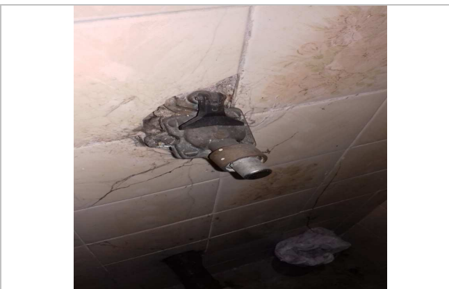
BANHEIRO (NECESSITA REFORMAS HIDROSANITÁRIO)
