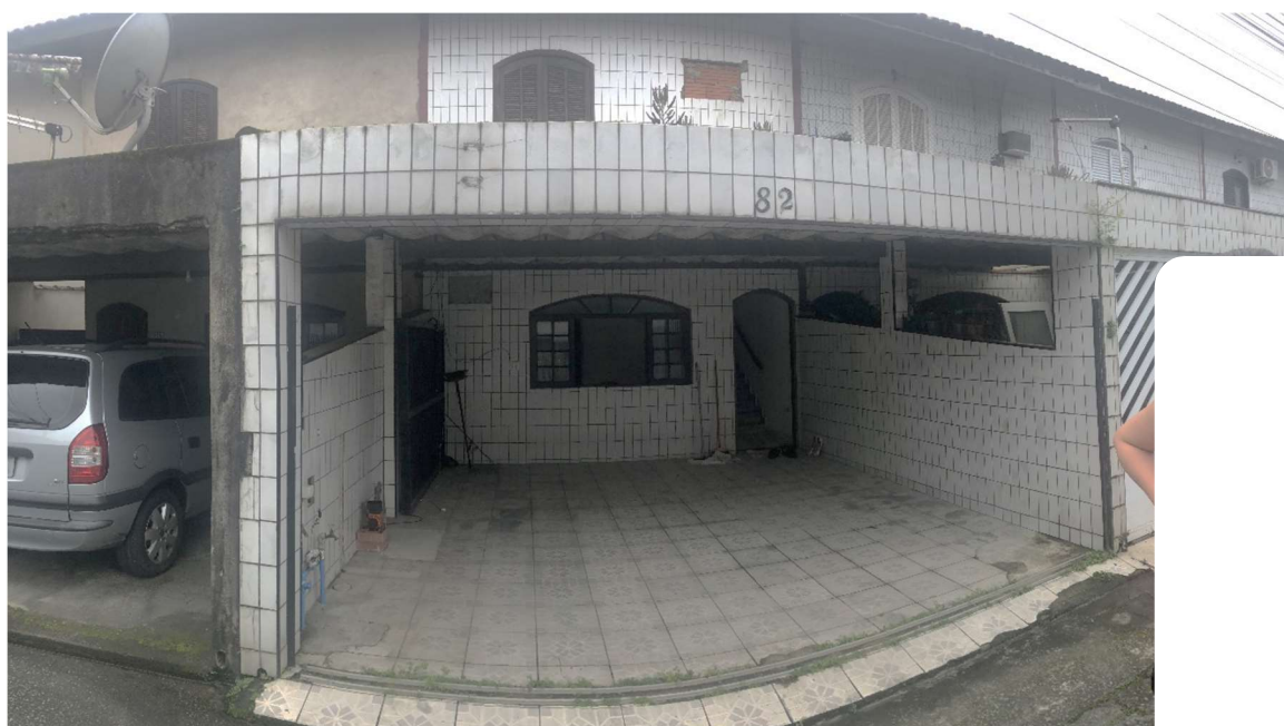
Figura 9 - Vista frontal da Casa nº82 residência avaliada.
