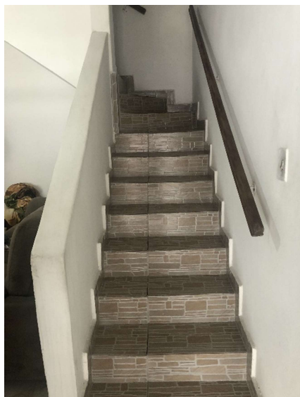
Figura 12 – Vista escada acesso ao pav. superior.
