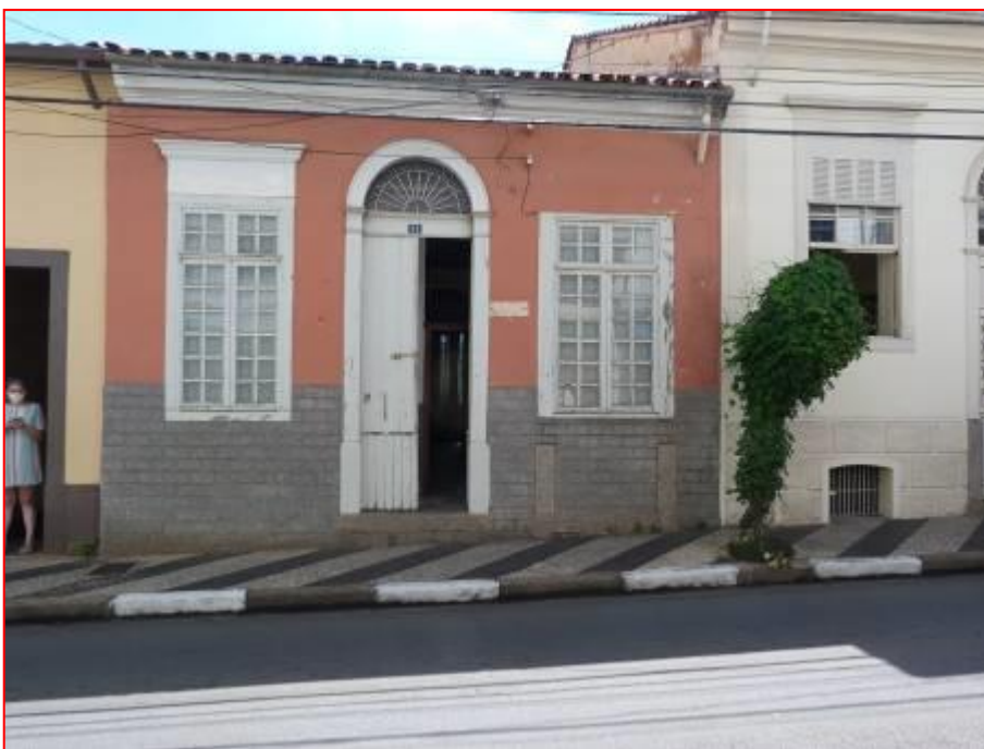
Foto 02: Vista da fachada do imóvel.
