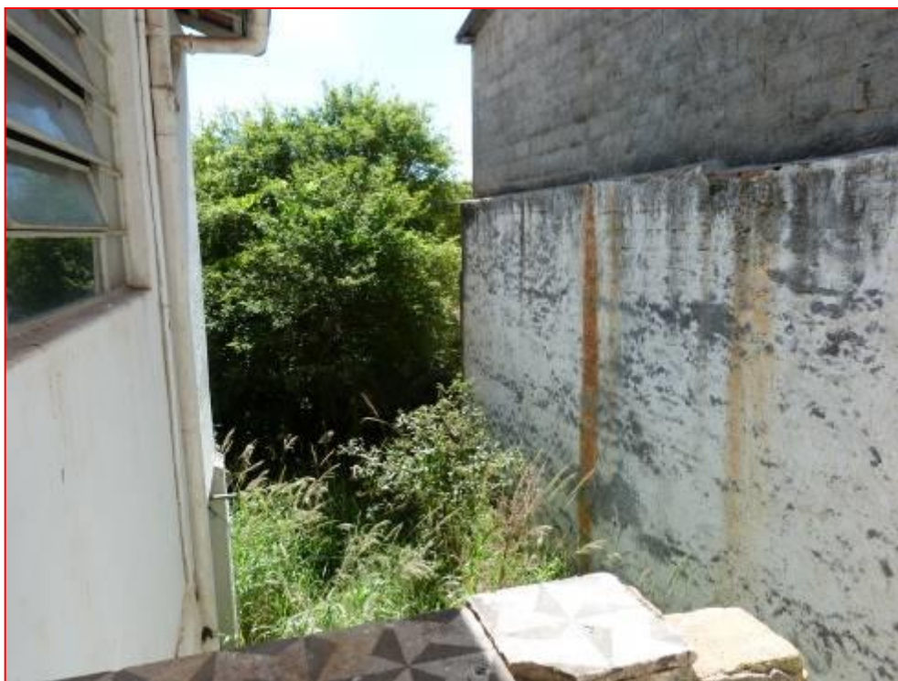
Foto 15: Vista da saída para o quintal da casa.
