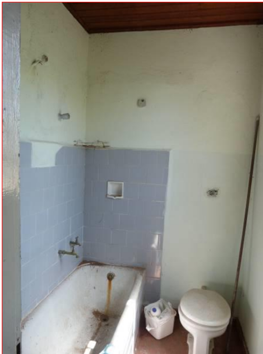
Foto 14: Vista do banheiro.
