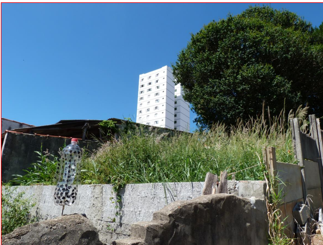
Foto 19: Vista do muro divisório dos fundos do imóvel.
