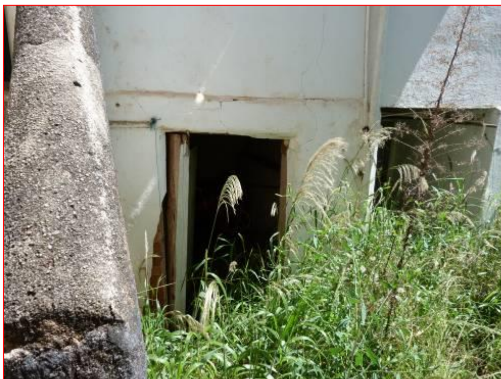
Foto 16: Entrada do porão inabitável.
