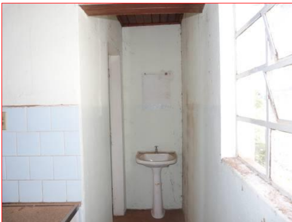
Foto 13: Vista do compartimento para a pia do banheiro.
