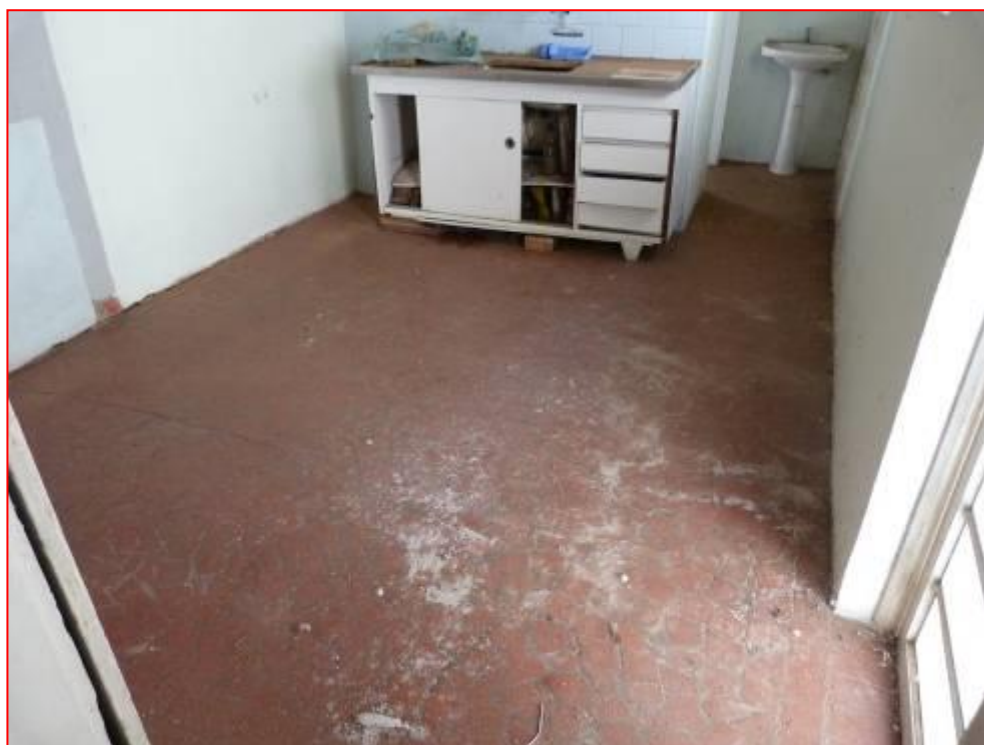
Foto 11: Vista da cozinha com piso em cacos cerâmicos.
