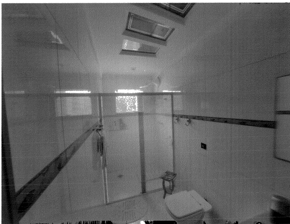
Foto 43: Banheiro do dormitório 2- 2º Pavimento
