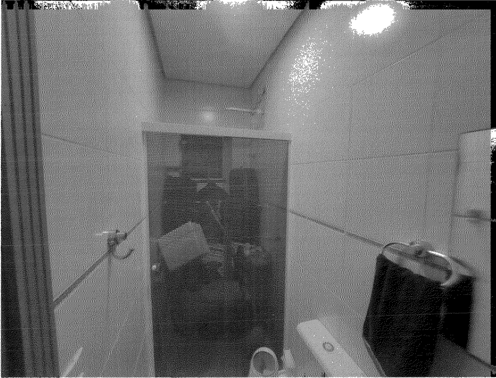
Foto 6: Banheiro do depósito - Térreo
