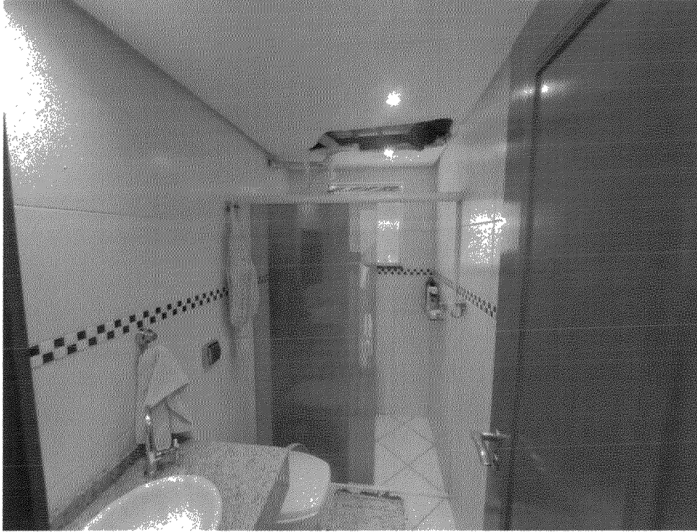
Foto 30: Banheiro externo- 1º Pavimento
