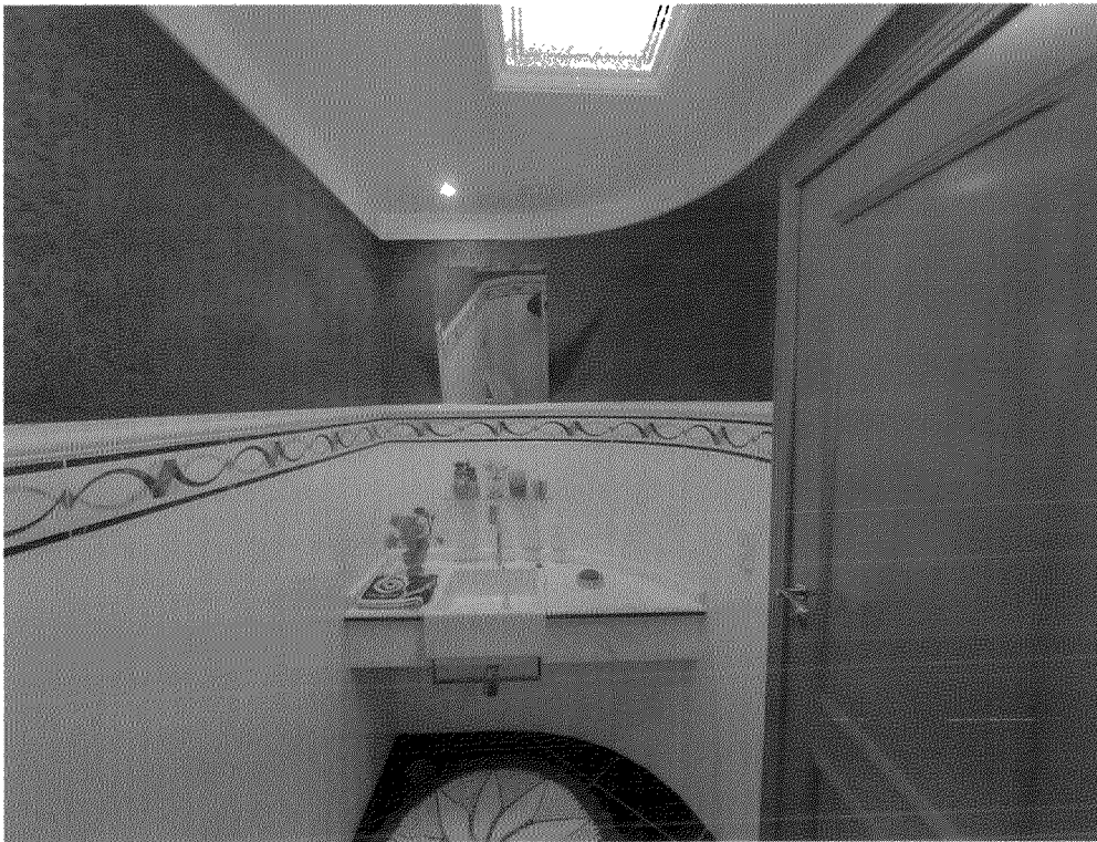
Foto 23: Lavabo- 1º Pavimento
