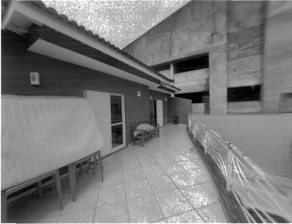
Foto 52: Varanda descoberta (acesso pelos dormitórios 3 e 4)- 2ºPavimento
