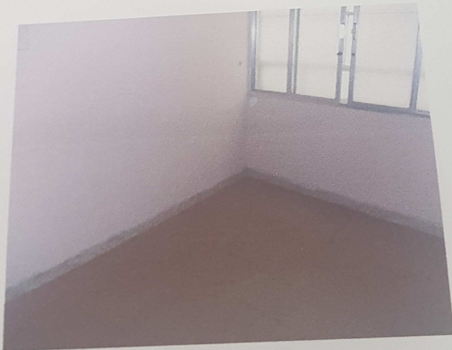
FOTO 03:- Vista interna do imóvel avaliando. Sala.
