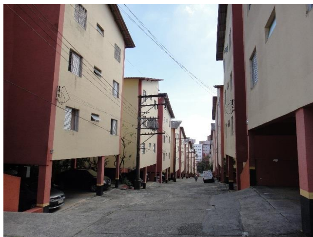
FOTO 10 – VISTA DA RUA INTERNA ATRAVÉS DA REGIÃO MAIS ALTA DO CONDOMÍNIO.
