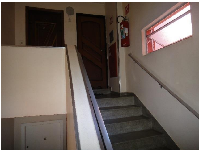
FOTO 11 – VISTA DAS ESCADAS DE ACESSO AO APARTAMENTO.
