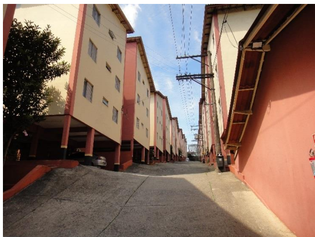
FOTO 6 – VISTA DA RUA INTERNA E ACESSO AOS DEMAIS BLOCOS DE APARTAMENTOS (ACLIVE).
