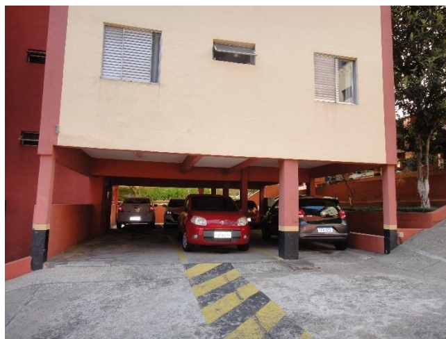
FOTO 22 – VISTA DA ÁREA DE ESTACIONAMENTO DE VEÍCULOS SOB O BLOCO 1.
