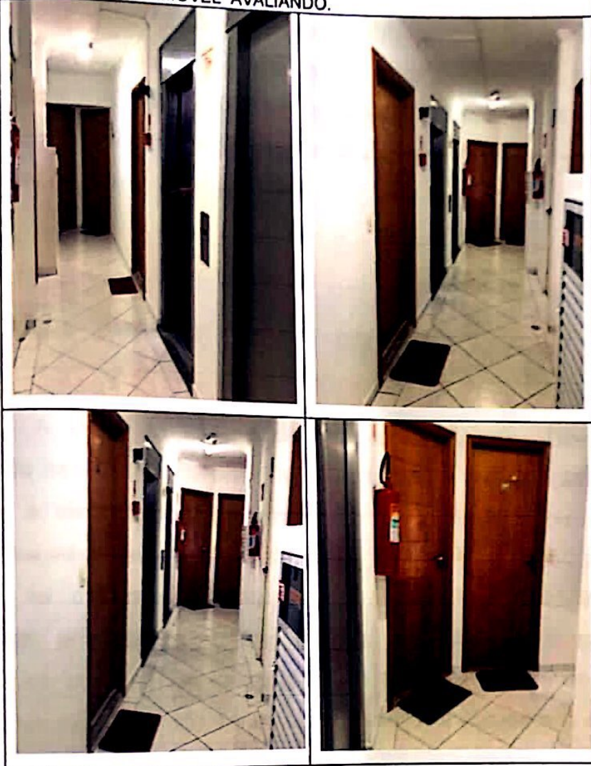
SÉRIE-FOTOGRAFICA 14 - DETALHES DO HALL DE CIRCULAÇÃO COMUM NO DÉCIMO-TERCEIRO PAVIMENTO TIPO, ONDE ESTÁ O IMÓVEL AVALIANDO.
