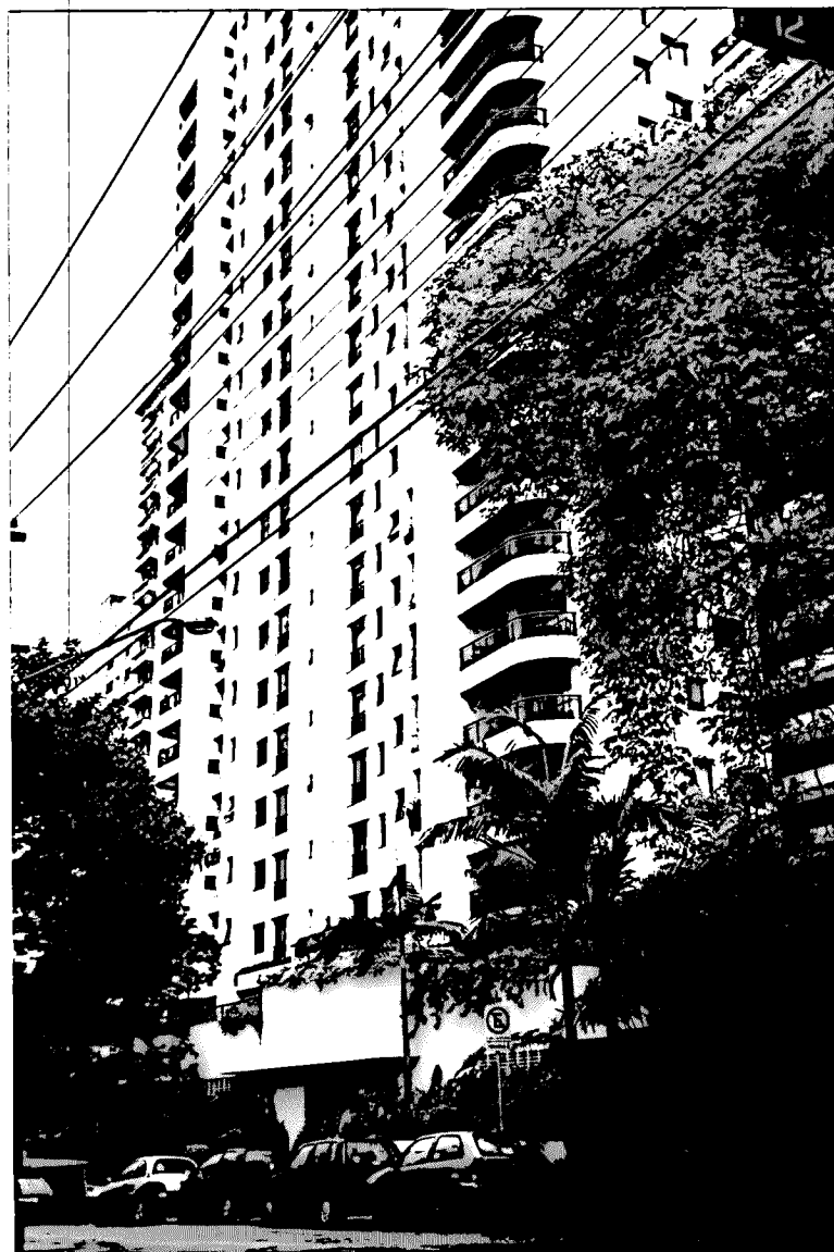
Vista da fachada do edifício
