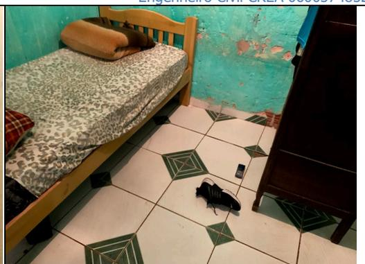
**Foto 04. Vista de um quarto com parede com infiltrações**
