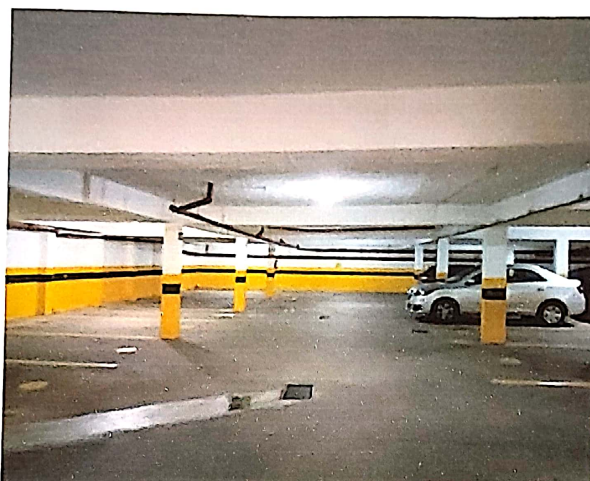
Foto 10 – Garagem no subsolo.
