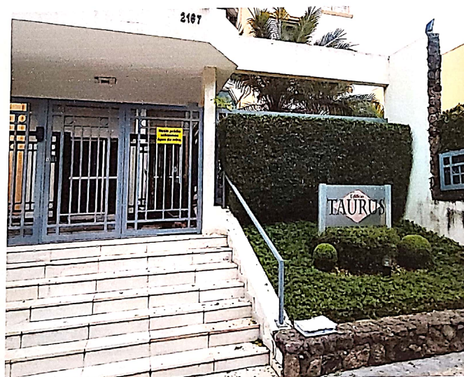
Foto 2 - Detalhe da entrada do Edifício Taurus.
