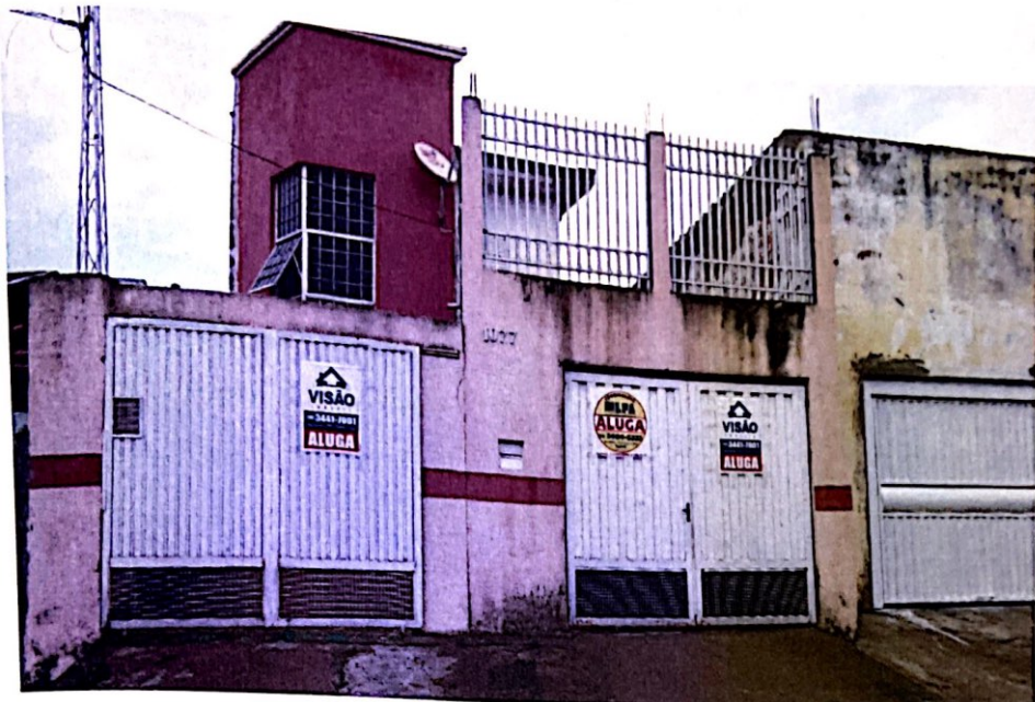
Vista parcial frontal externa do imóvel avaliando, observando a fachada da residência endereçada sob o nº 1.077 da Rua São Paulo.
