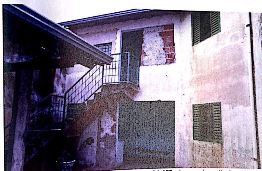
Vista parcial interna da residência sob o nº 1.077, observando a edícula.
