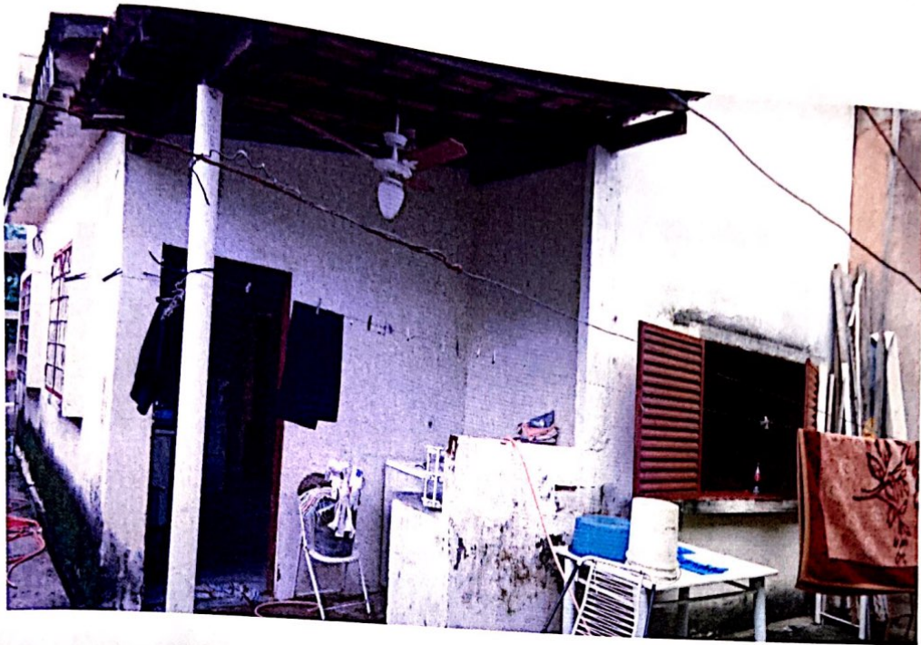
Vista parcial interna da residência sob o nº 1.081, observando os fundos.
