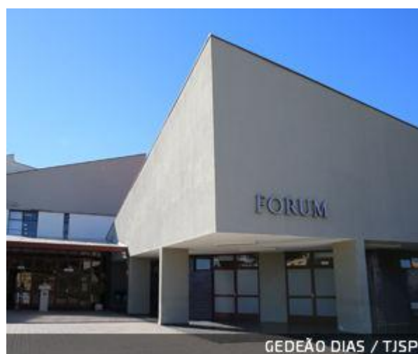
Inaugurado em 2003, fórum foi interditado em 2014 por problemas na estrutura.
