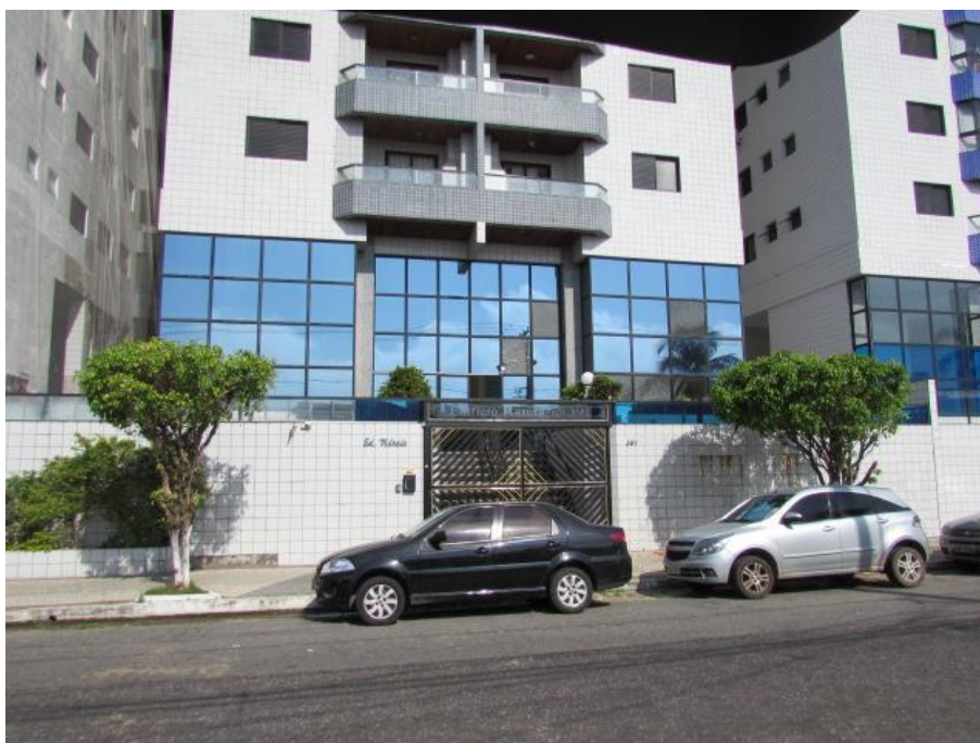
Foto 02 – Vista da fachada do Bloco III.
