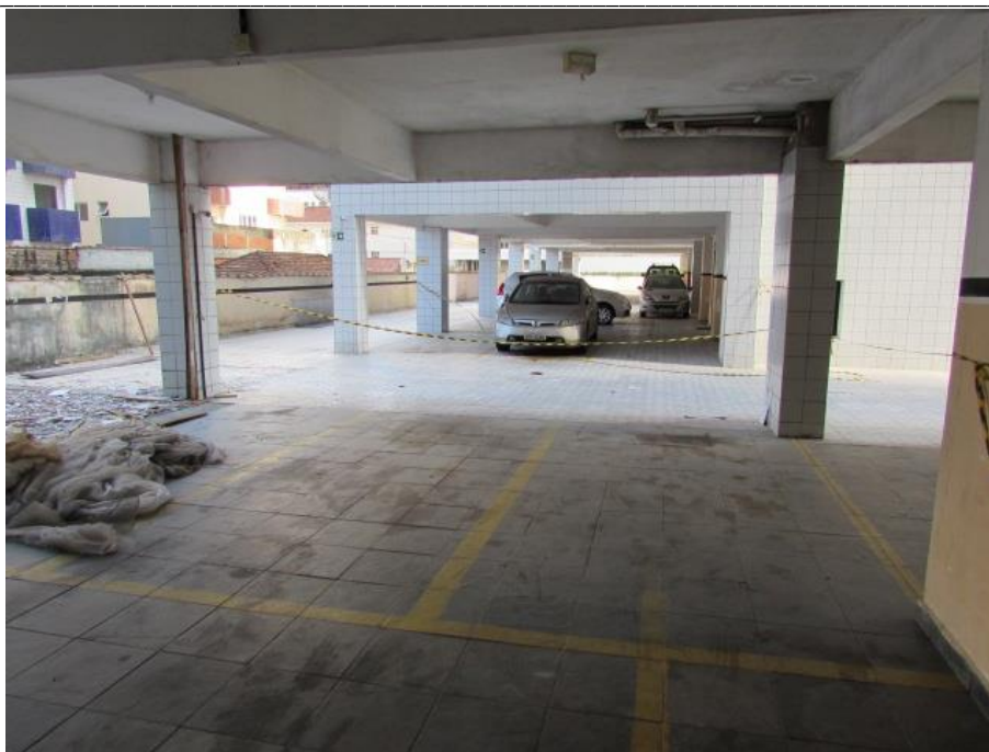
Foto 04 – Vista das vagas de garagem no pavimento térreo do Bloco III do Condomínio Edifício Márcia de Fátima.
