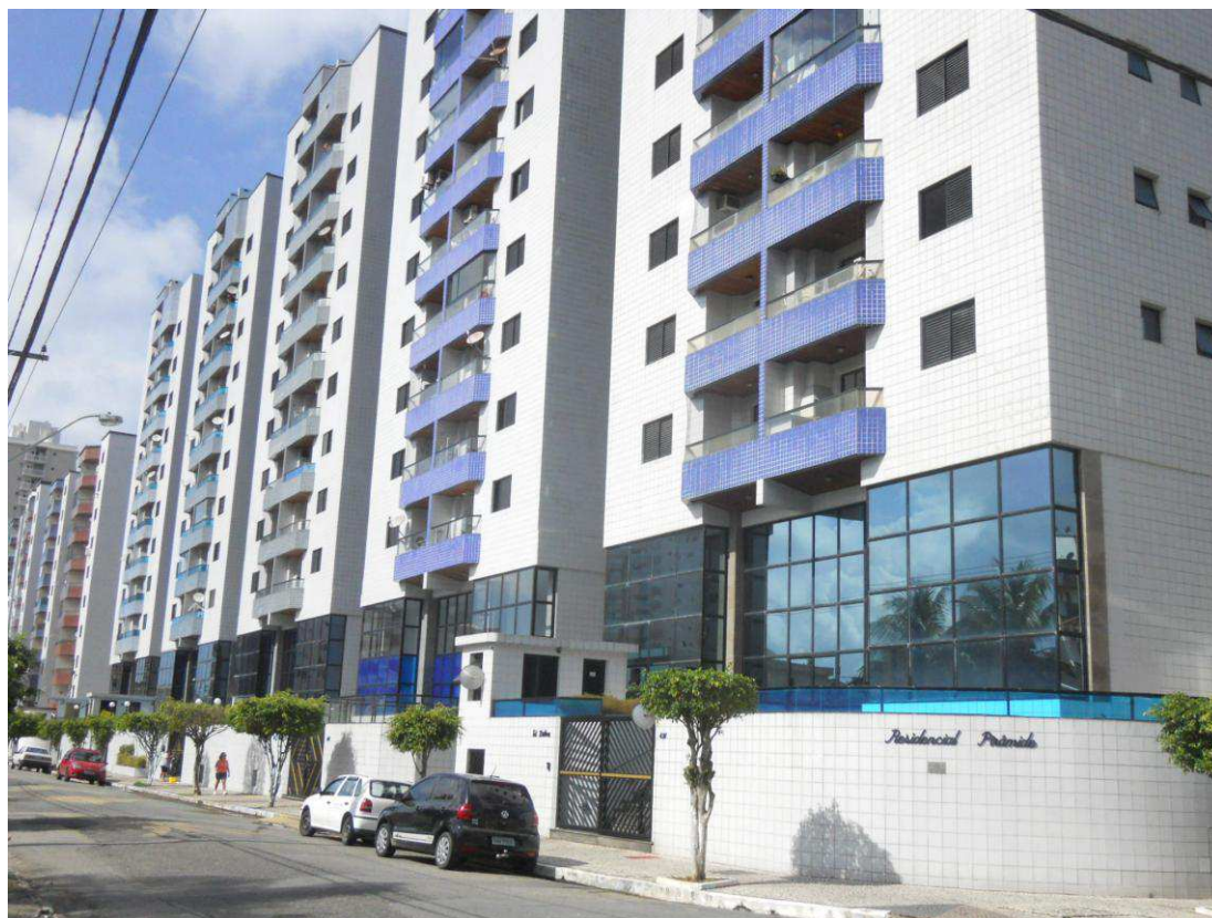
FOTO 8 (Anexo IV) – Foto da Rua Monteiro Lobato, Relatando os edifícios que compõe o Conjunto Residencial (seguido em frente, ao final desta rua teremos o Praia)
