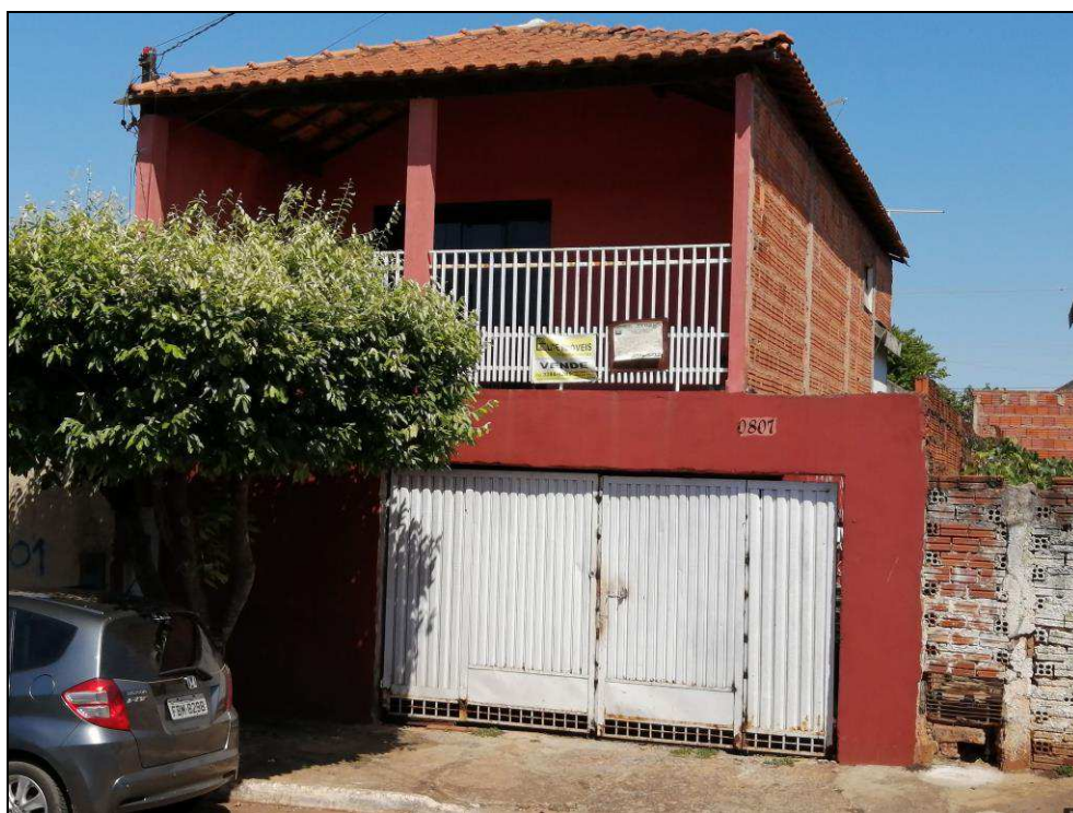
FOTO Nº 01:- Detalhe parcial do imóvel com frente para a Rua José Hermoso Fernandez, nº O-807.
