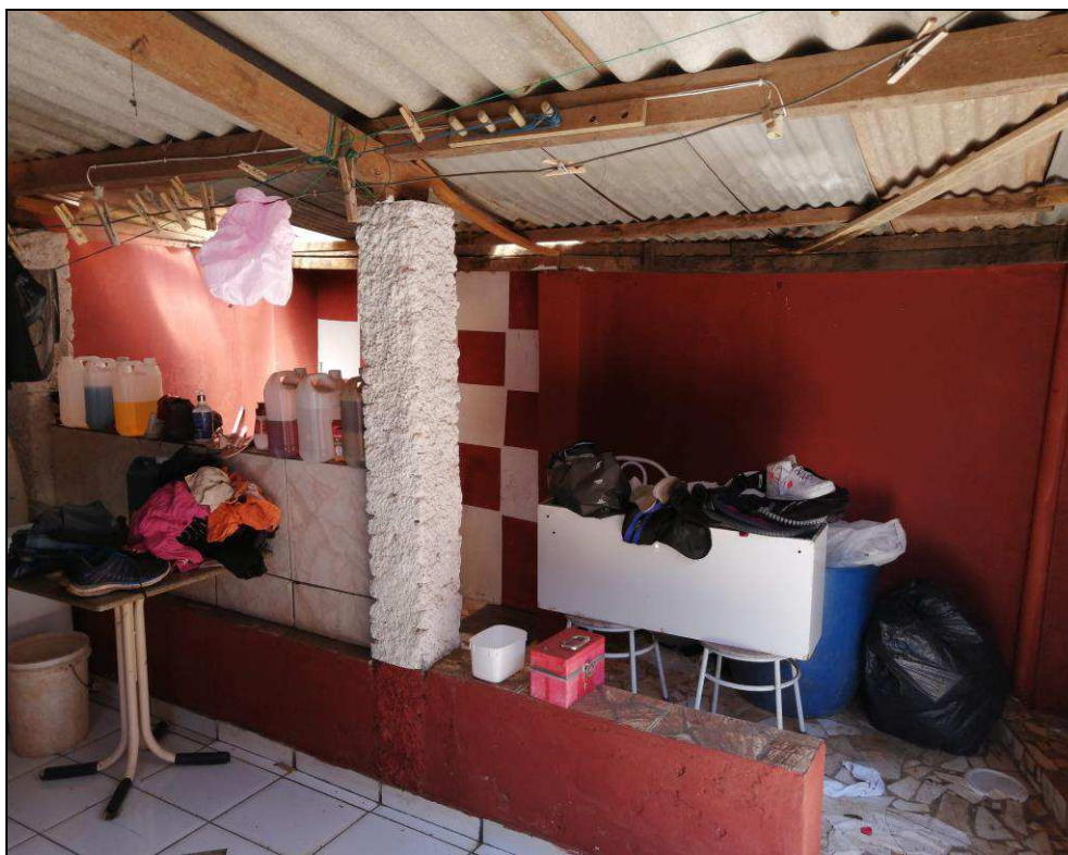
FOTO Nº 12:- Detalhe parcial da cobertura existente na parte dos fundos do imóvel.
