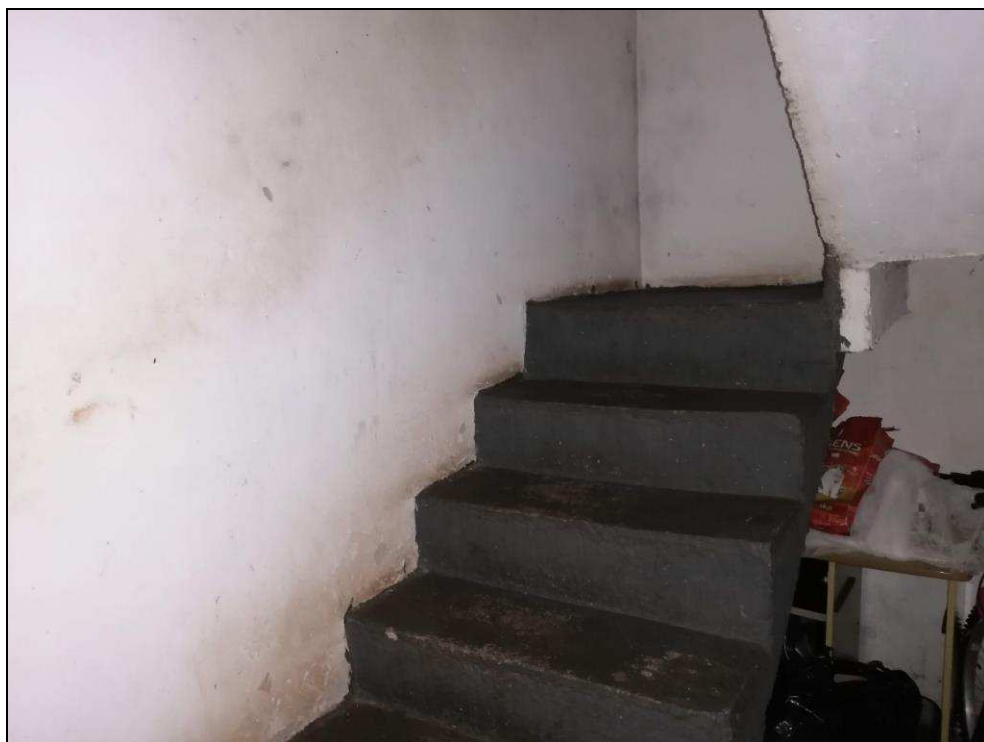
FOTO Nº 05:- Detalhe parcial da escada de acesso ao pavimento superior.
