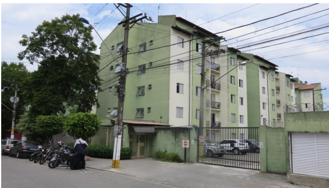
Figura 7: Vista parcial da testada do Conjunto Residencial San Marino II pela Rua Pau do Café.
