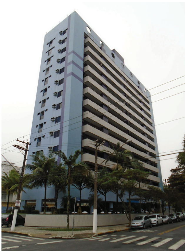
Foto 03 – Vista geral do edifício
