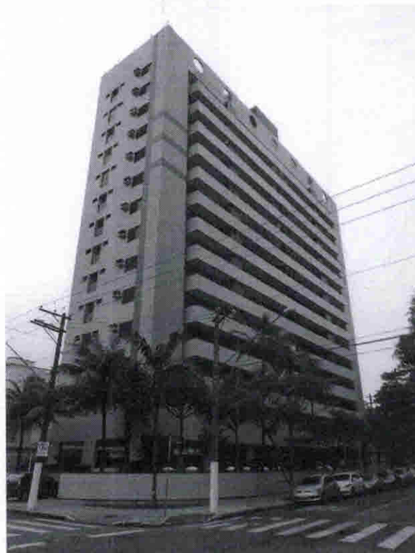
Foto 03 – Vista geral do edifício
