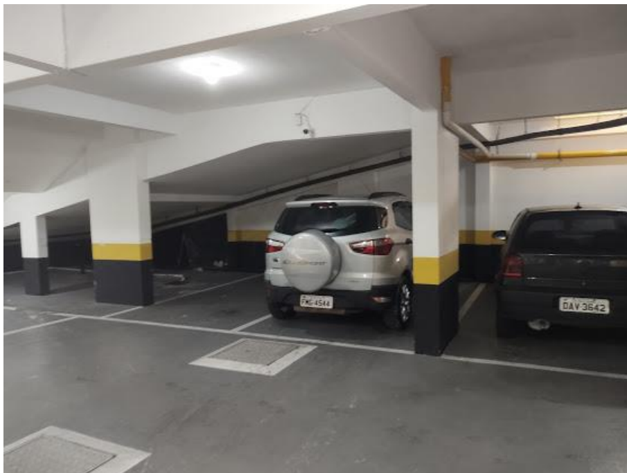
Foto 07 – Vista das vagas de garagem localizadas no subsolo do Edifício Residencial Max IV.
