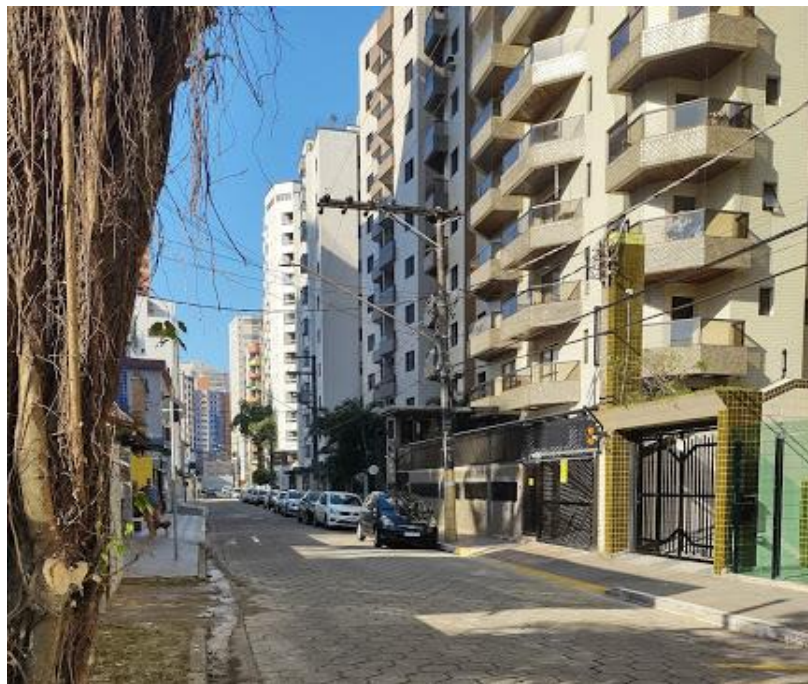
Foto 01 – Vista da Rua Padre José de Anchieta a esquerda de quem olha para o Edifício Residencial Max IV.
