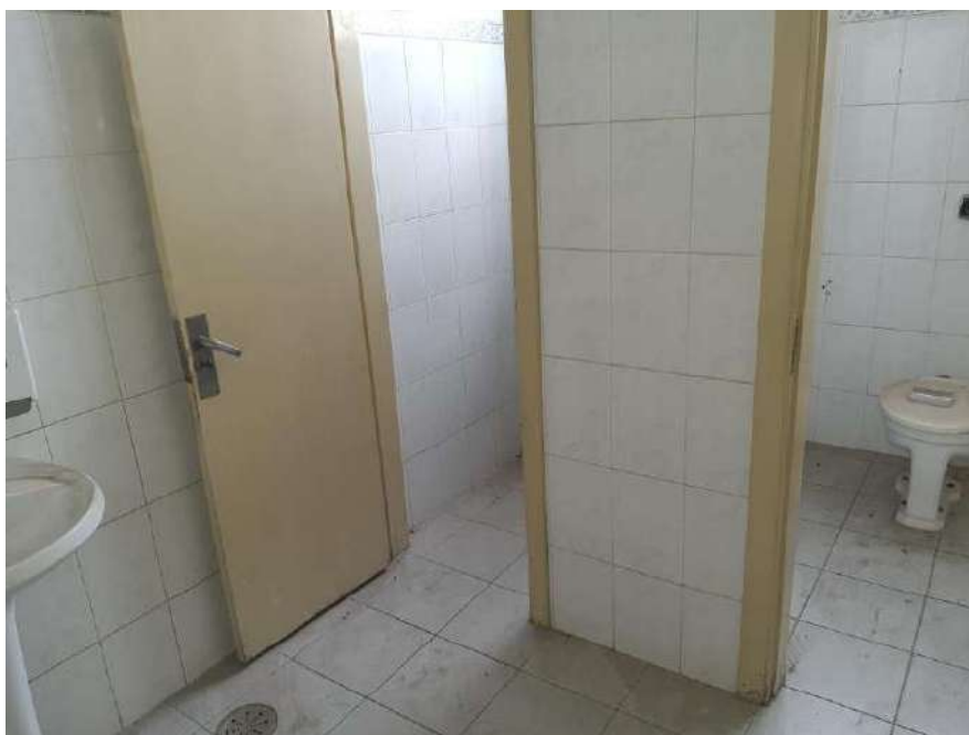
Foto 5: Vista interna de um dos banheiros (Prédio Administrativo)
