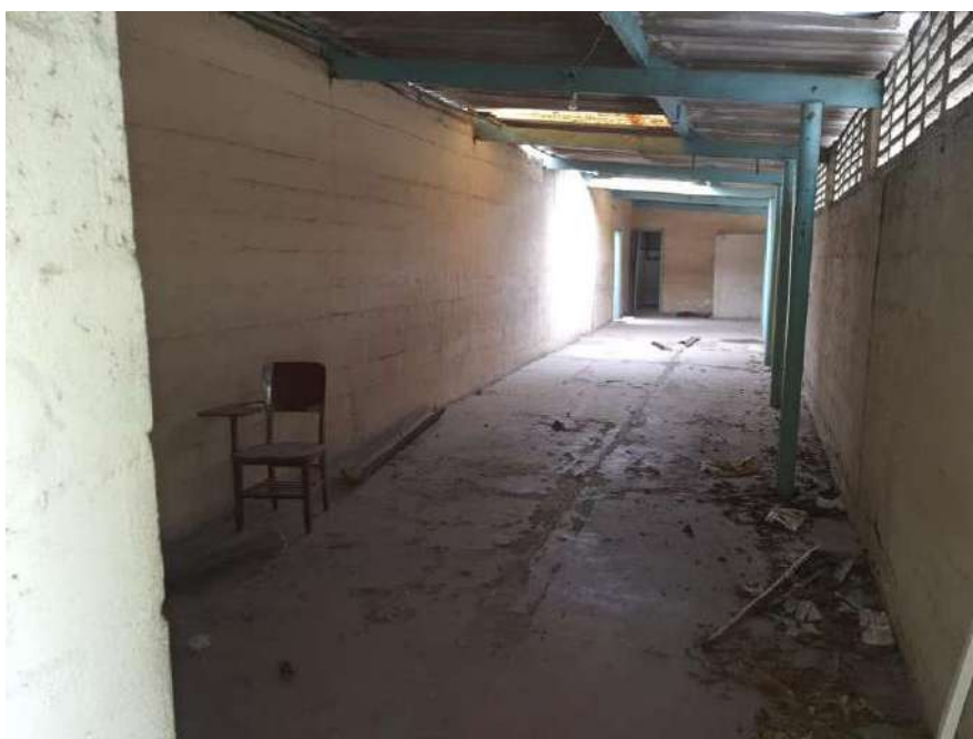
Foto 6: Vista do Vestiário (térreo)
