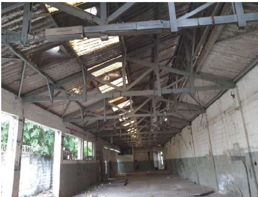
Foto 11: Vista do Galpão em “L” (lateral direita)
