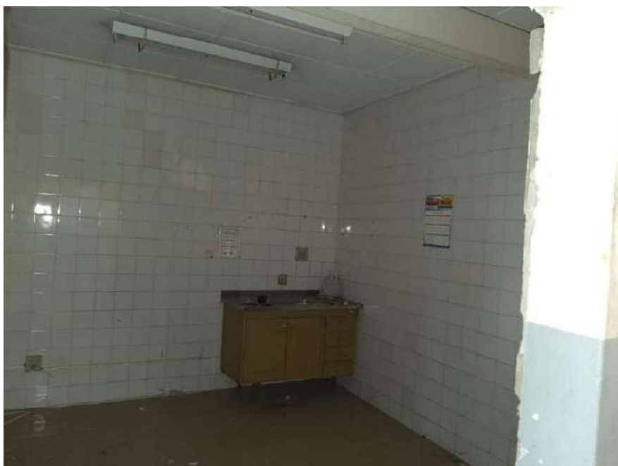
Foto 7: Vista da Cozinha
