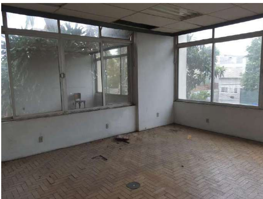
Foto 4: Vista Interna do Prédio Administrativo
