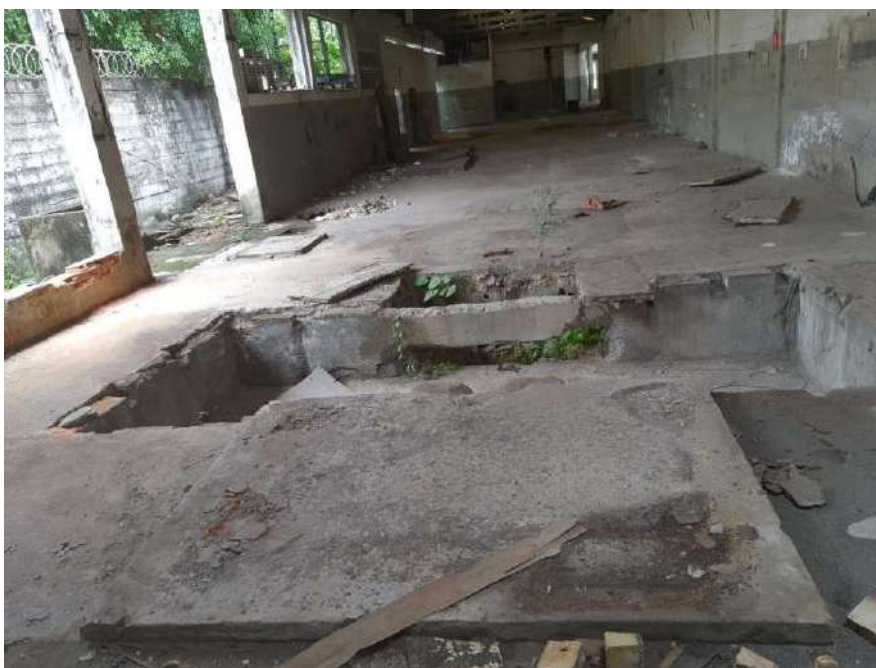
Foto 12: Outra Vista do Galpão em “L” (lateral direita)
