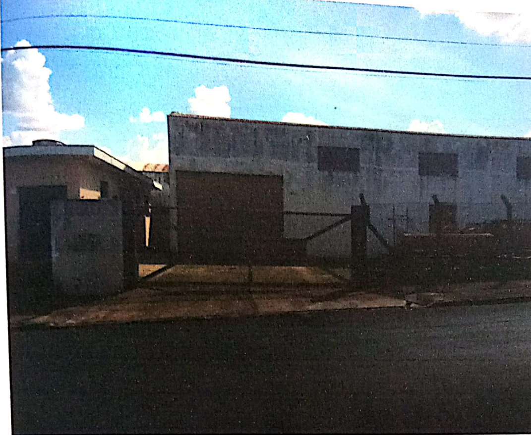
Figura 03 – Fachada do Imóvel Avaliando
