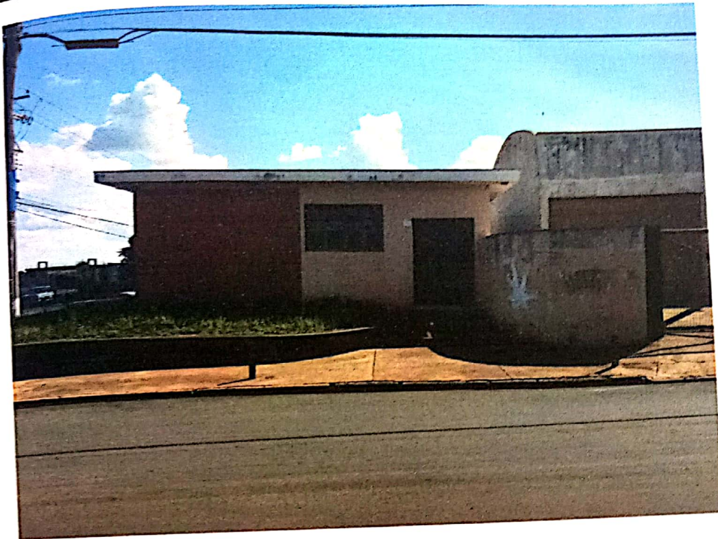
Figura 05 – Fachada do Imóvel Avaliando
