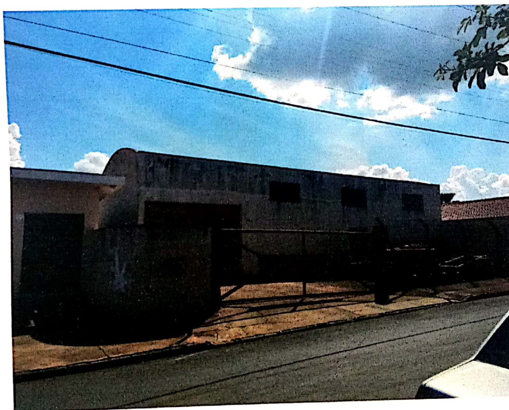
Figura 04 – Fachada do Imóvel Avaliando
