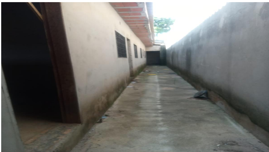
Corredor Lateral e lavanderia nos Fundos
