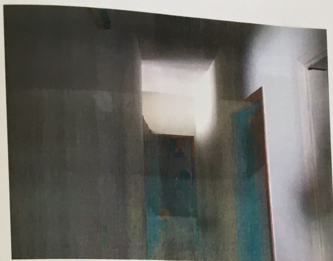
Vista do corredor interno
