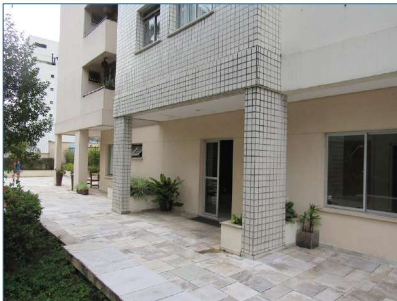
Foto de nº 24 - Acesso ao edifício.
