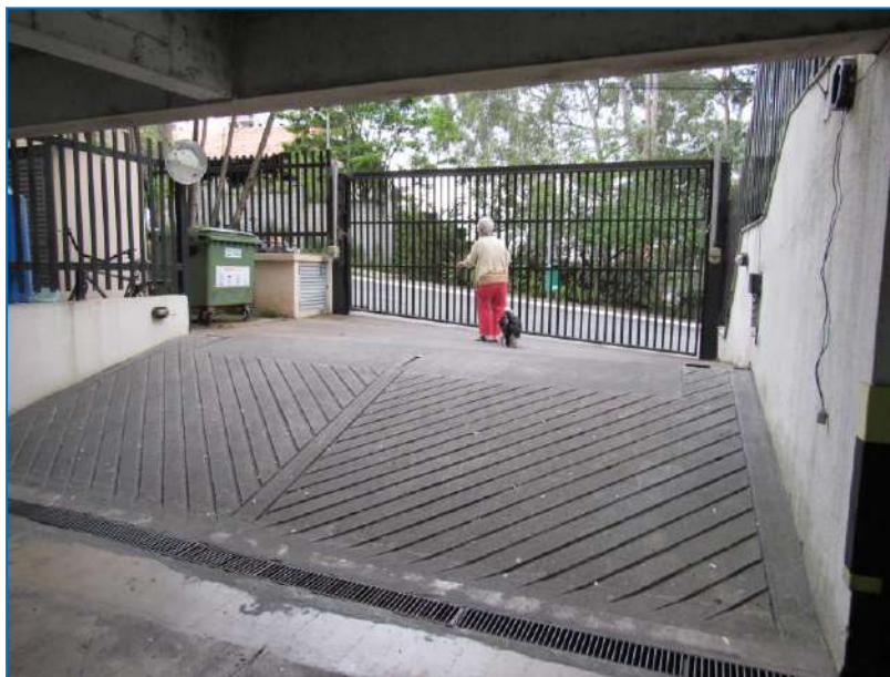
Foto de nº 09 - Acesso ao subsolo do edifício.
