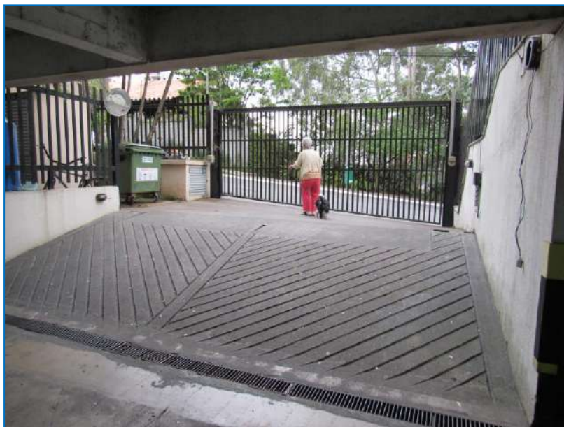
Foto de nº 09 - Acesso ao subsolo do edifício.
