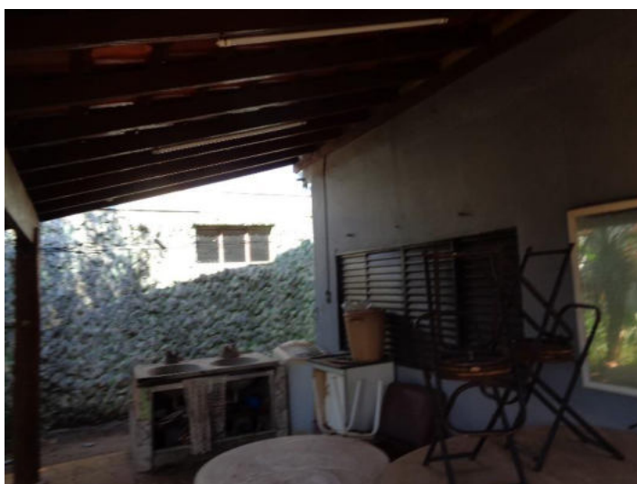
Abrigo depois da cozinha: sem forro, cobertura estrutura de madeira telhas cerâmicas.
