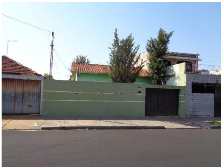
Vista do imóvel pela via pública.
