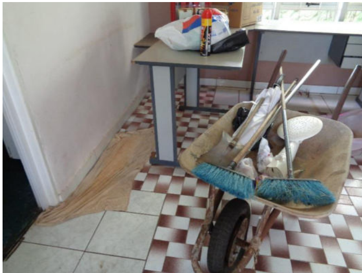
Parte da copa: piso cerâmico.
