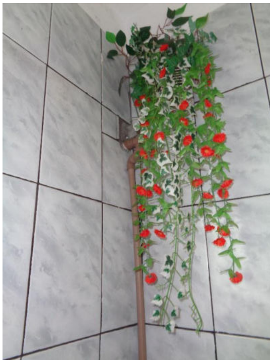
Banheiro: Tubulação externa.
