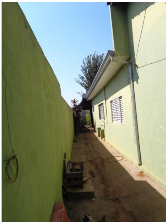
Corredor externo lateral esquerdo.
