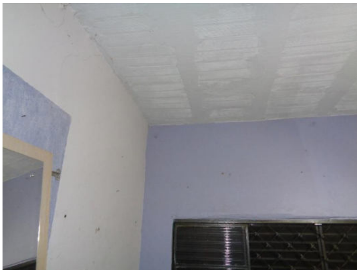
Parte de quarto ao lado da copa: forro laje, paredes reboco com pintura.
