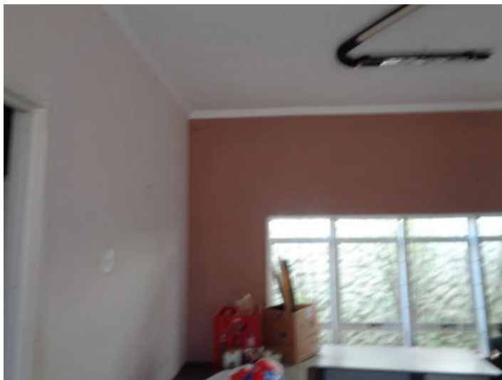
Parte da copa: forro laje, paredes reboco com pintura.
