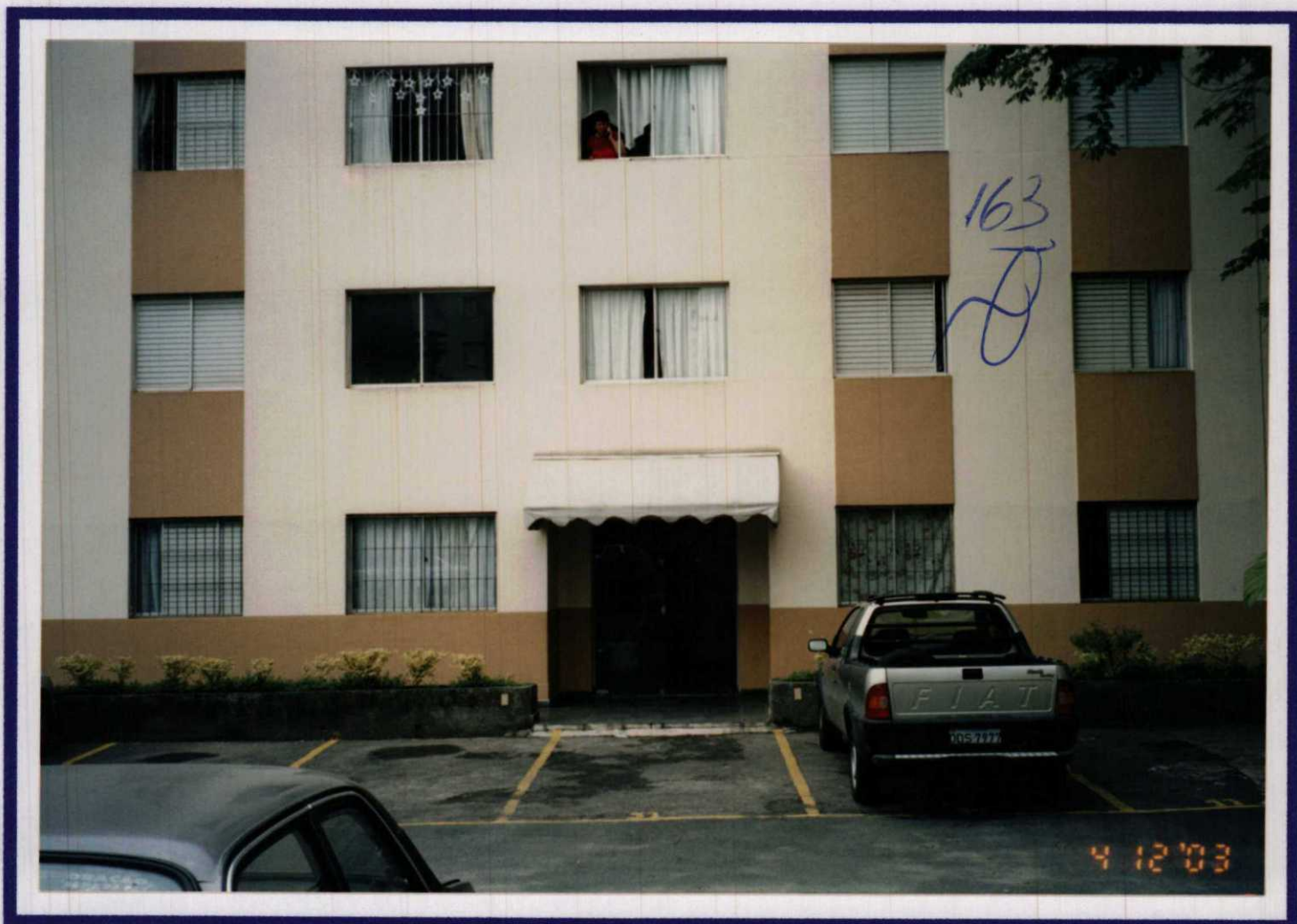
Foto 4 – Vista da entrada do Bloco II.
