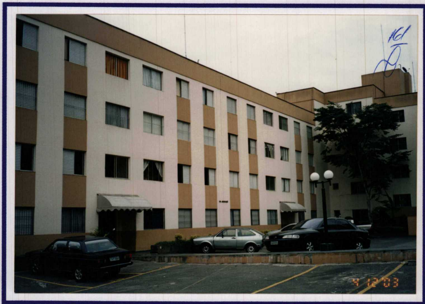
Foto 2 – Vista geral do condomínio.
