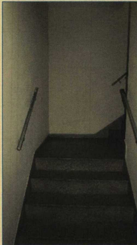
HALL SOCIAL E ESCADA DE ACESSO AOS APARTAMENTOS.
