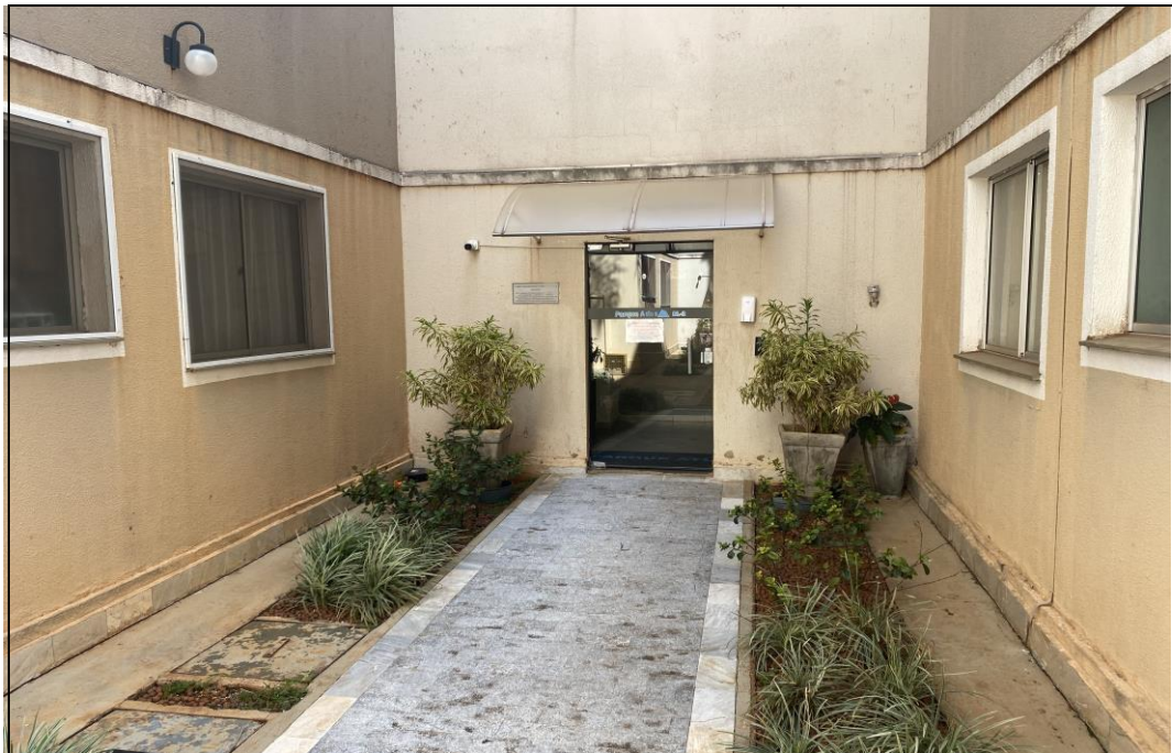
FOTO 03 – Vista geral da porta de entrada do bloco.
