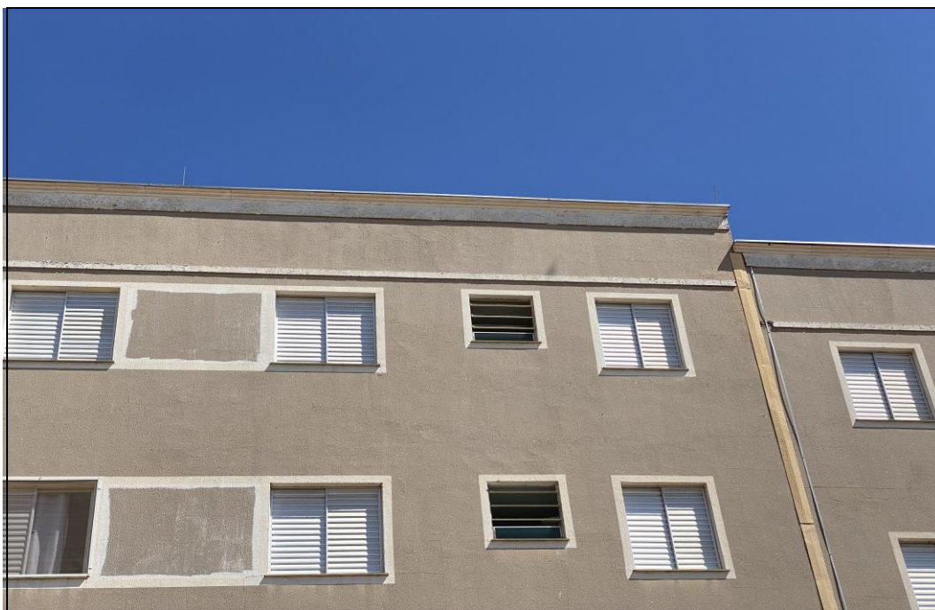
FOTO 05 – Vista externa da esquadria lateral do imóvel.
