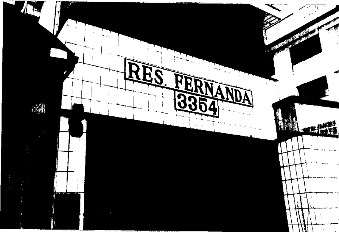
Foto nº 5 – detalhe da fachada
