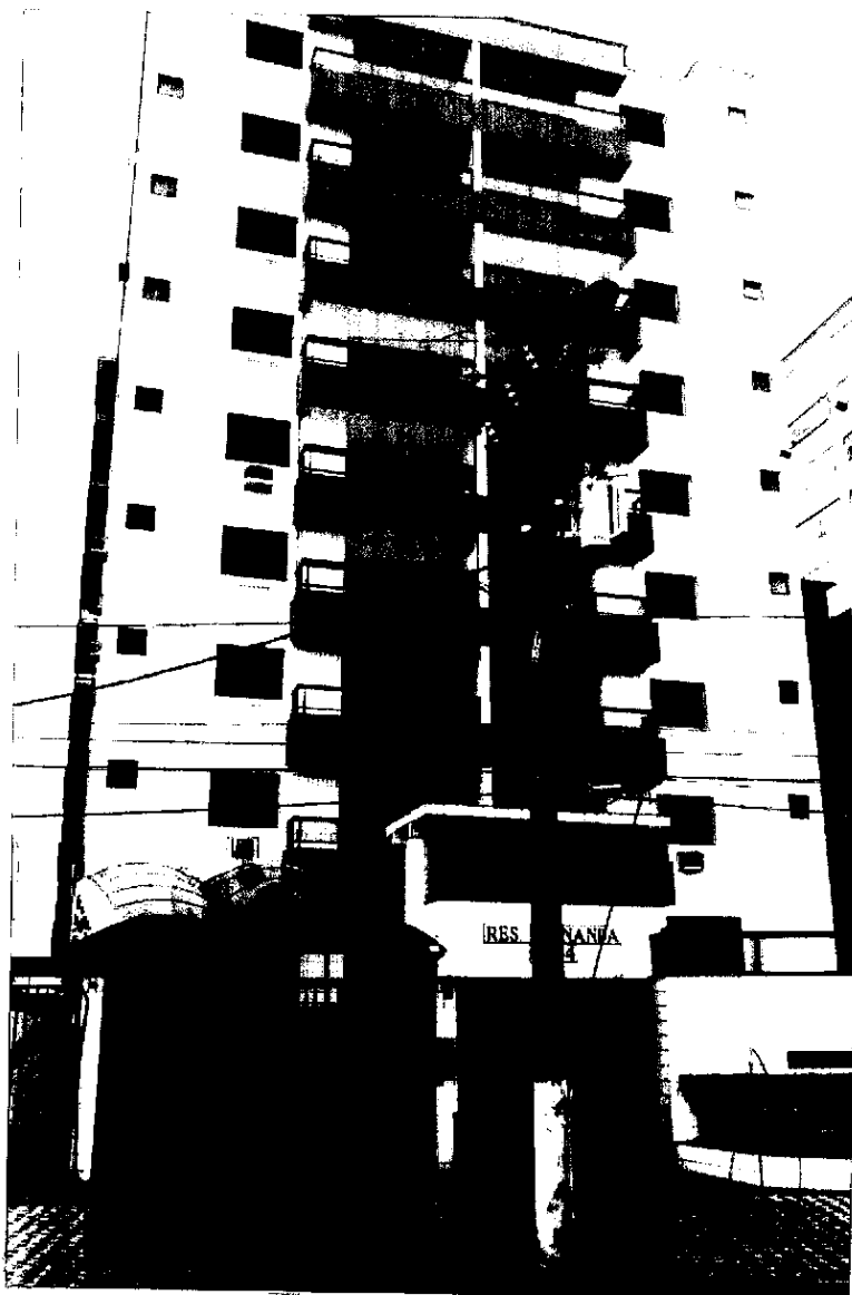
Foto nº 01 – fachada do Condomínio Edifício Residencial Fernanda - Bloco A, do apartamento nº 413 avaliando, frente para Av. Pres. Castelo Branco
