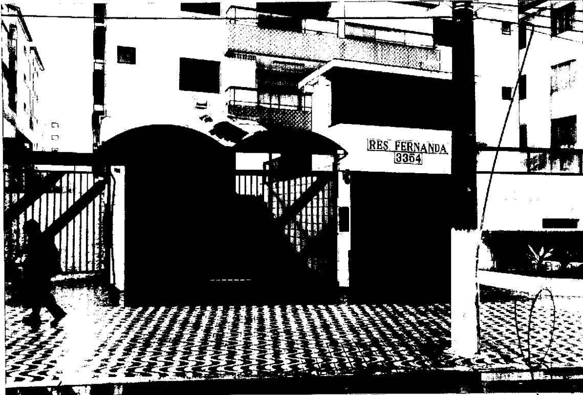
Foto nº 4 – detalhe da fachada com portal de acesso ao Condomínio
