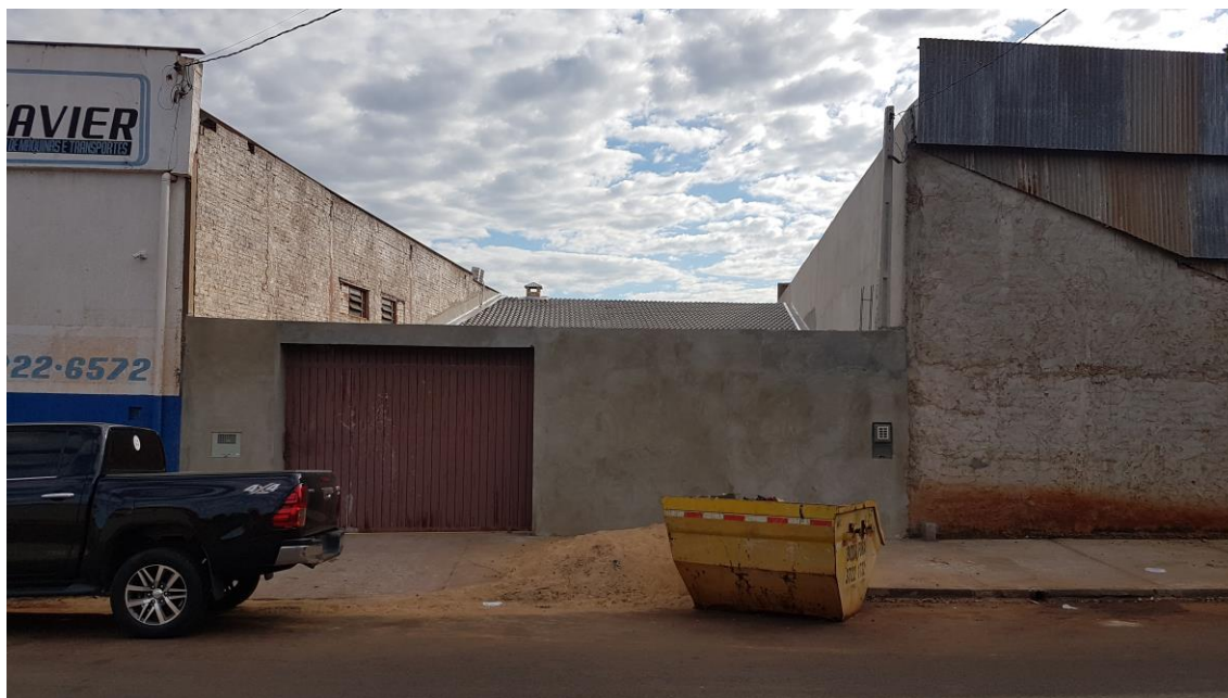
FOTO 1 – VISTA FACHADA – RUA SANTA AMÁLIA
