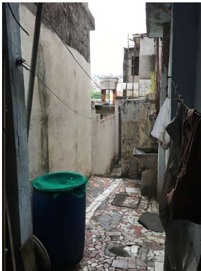
VISTA DA PAREDE DO CORREDOR DO SUBSOLO.
