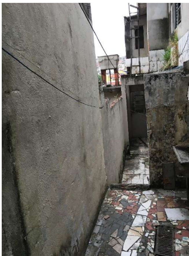
VISTA DA PAREDE DO CORREDOR DO SUBSOLO.
