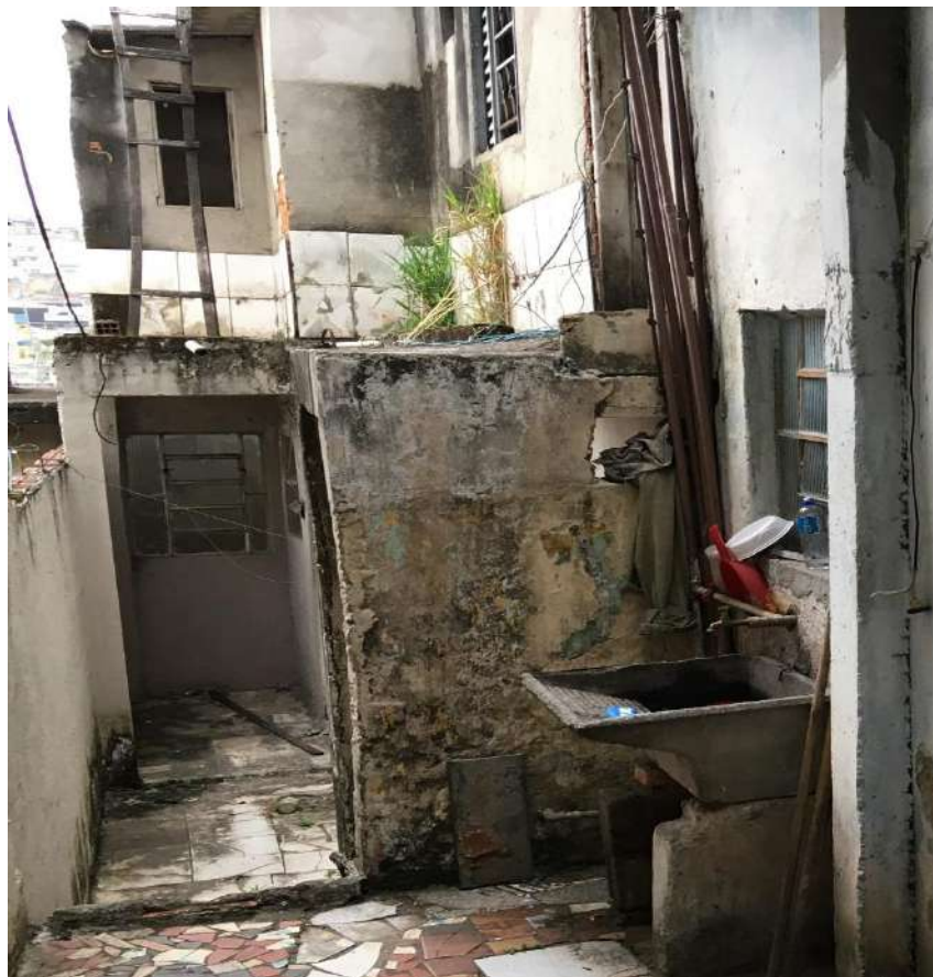
VISTA DO TANQUE E O ACESSO AO PRIMEIRO PAVIMENTO DO SUBSOLO.
