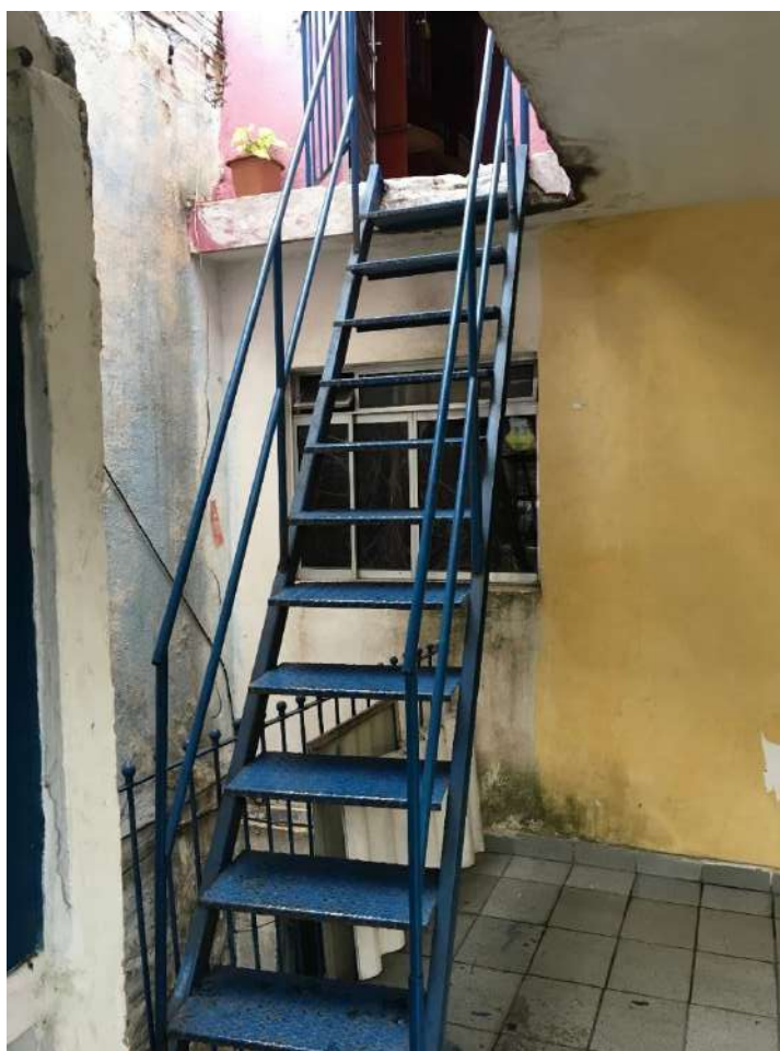
VISTA DA ESCADA DE ACESSO A CASA 02.
