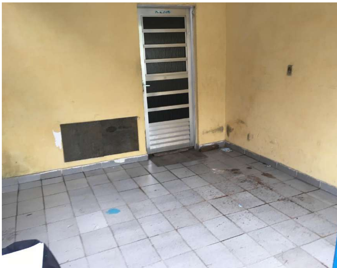
VISTA DA GARAGEM.
