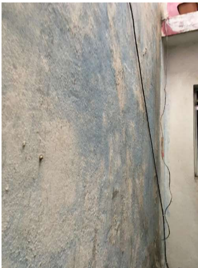
VISTA DA PAREDE DA ESCADA DO SUBSOLO.
