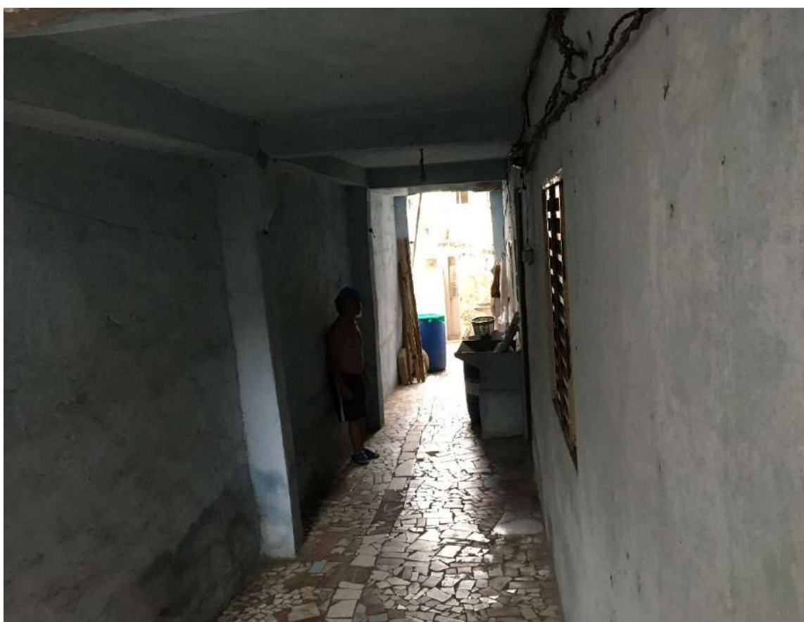
OUTRA VISTA DA PAREDE DO CORREDOS DO SUBSOLO.
