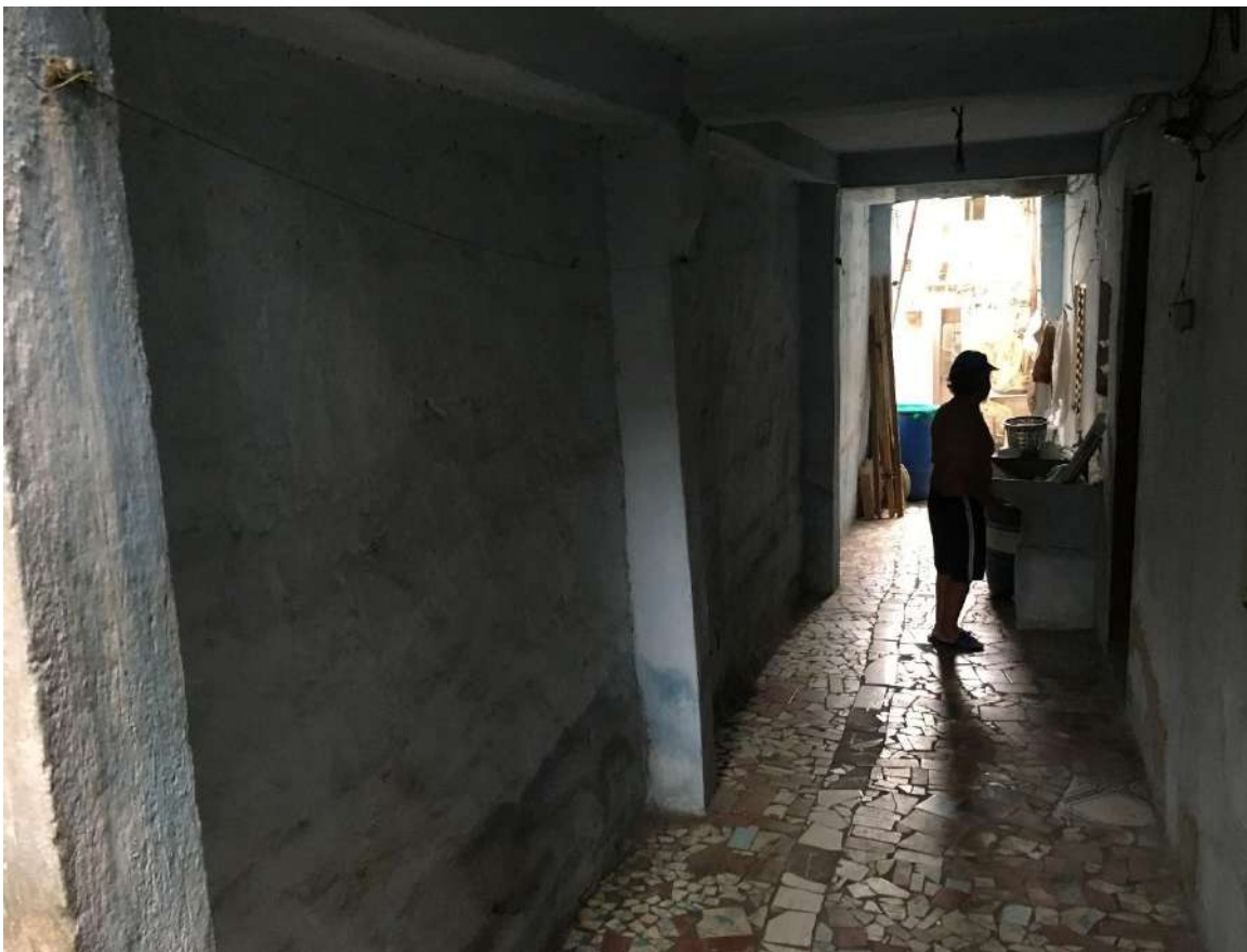
VISTA DA PAREDE DO CORREDOR DO SUBSOLO.
