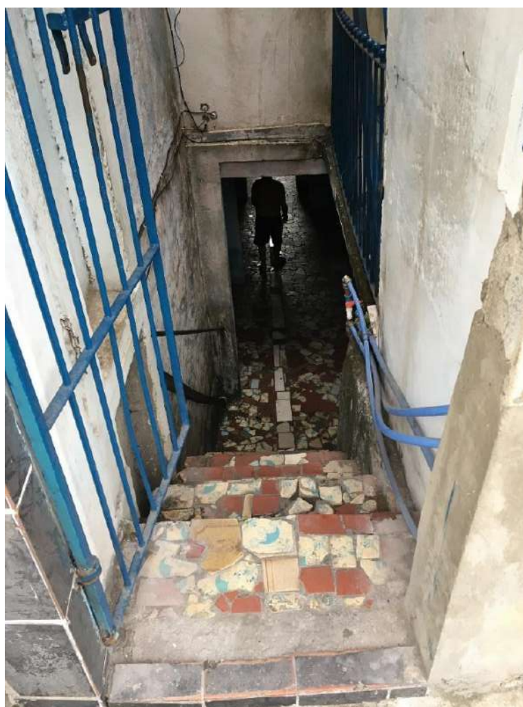
VISTA DA ESCADA DE ACESSO AO SUBSOLO.
