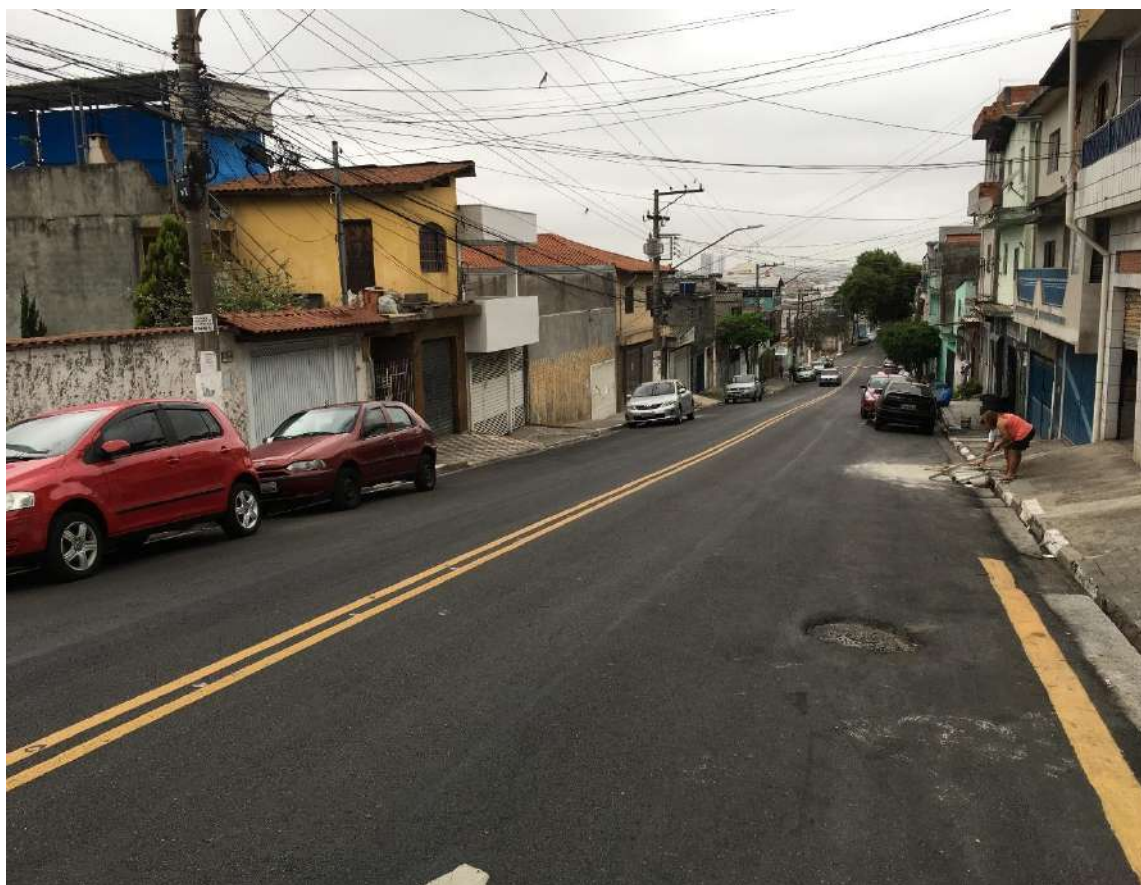
VISTA, NO SENTIDO CONTRÁRIO DE DIREÇÃO, DA VIA.
