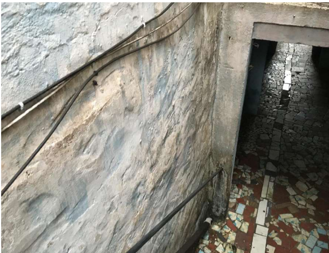
OUTRA VISTA DA PAREDE DA ESCADA DO SUBSOLO.
