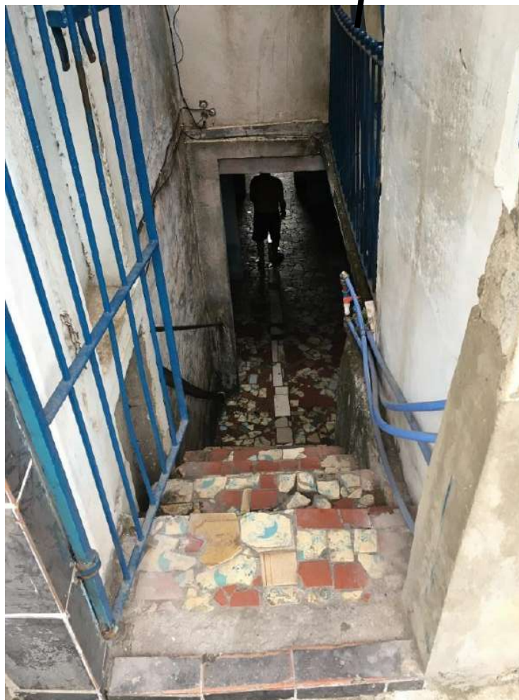
VISTA DAS PAREDES DA ESCADA DO SUBSOLO.
